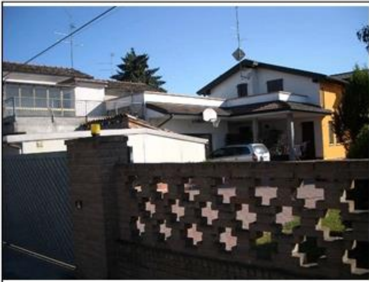
Vista da: Nord
