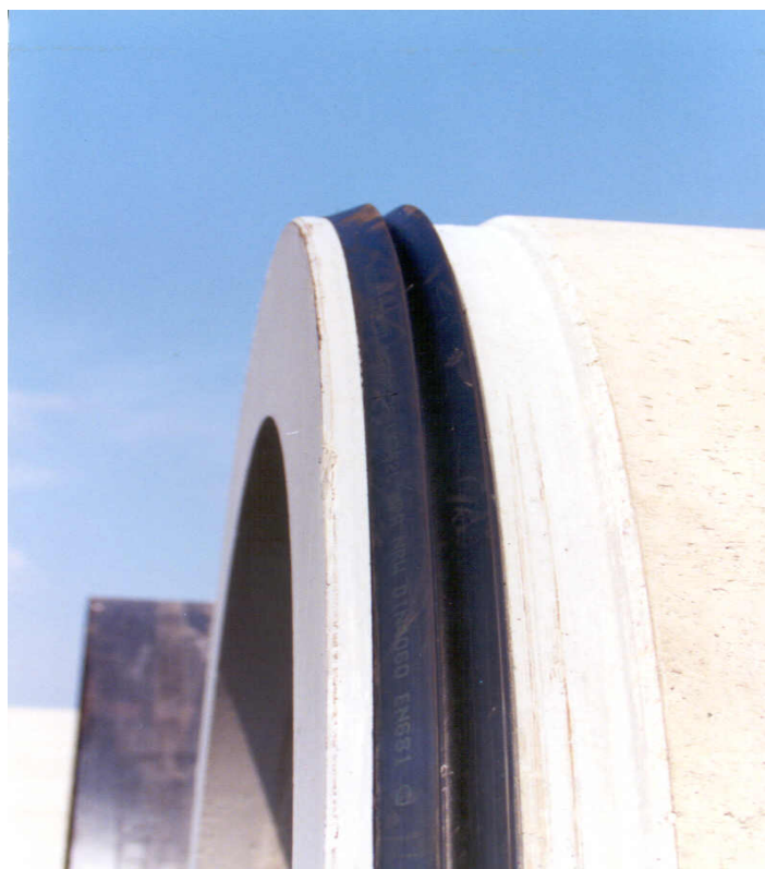
Fig.8: Particolare giunto di tenuta (tecnica del microtunnelling)
