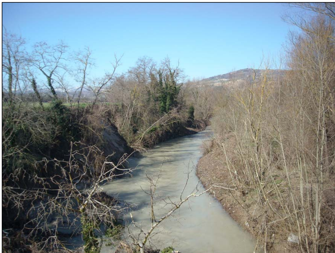
Fig.3.3: Foto ambito d'attraversamento
