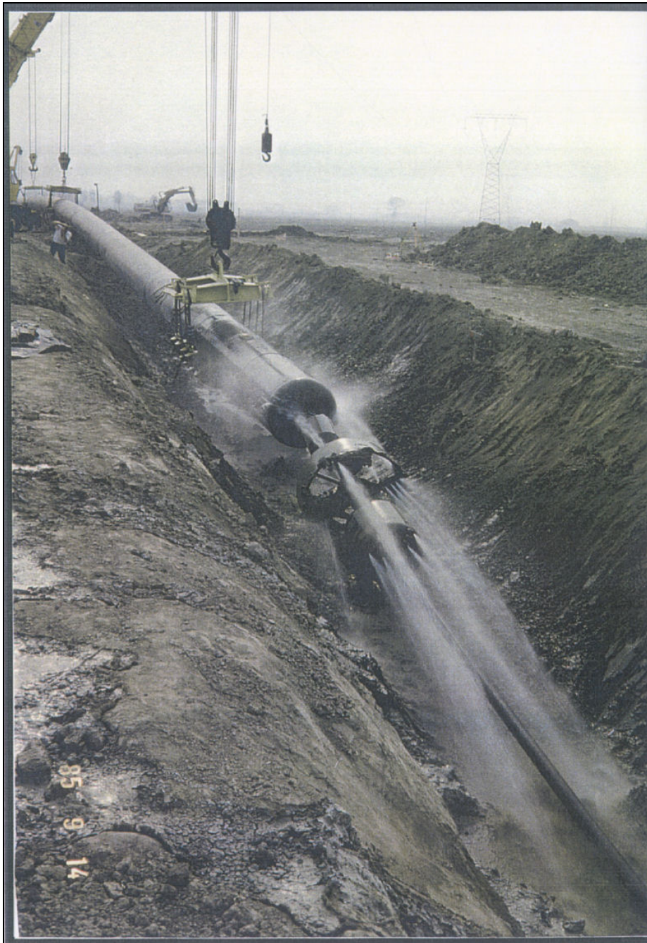
Attravers. T. Samoggia con met. 42" Inizio della fase di "tiro-posa" della condotta
