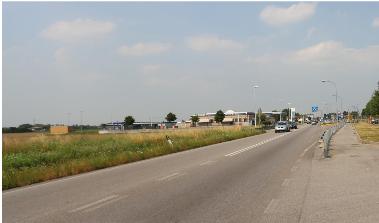
FIGURA 3-22 LOC. CALVECCHIA - VISTA RELATIVA AL PUNTO DI PERCEZIONE DINAMICA VELOCE 2V – STATO DI FATTO
