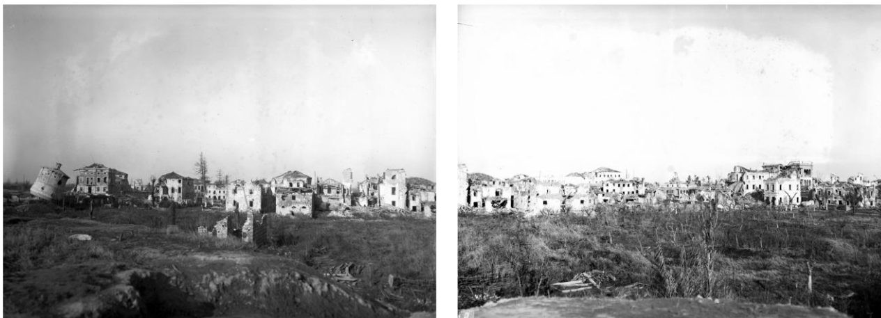
FIGURA 3-28 ARCHIVIO FOTOGRAFICO SOPRINTENDENZA BELLE ARTI E PAESAGGIO PER LE PROVINCE DI VENEZIA, BELLUNO, PADOVA E TREVISO SAN DONÀ DI PIAVE: VEDUTE PANORAMICHE DELLE ROVINE DEL PAESE RASO AL SUOLO DALLE NOSTRE ARTIGLIERIE
