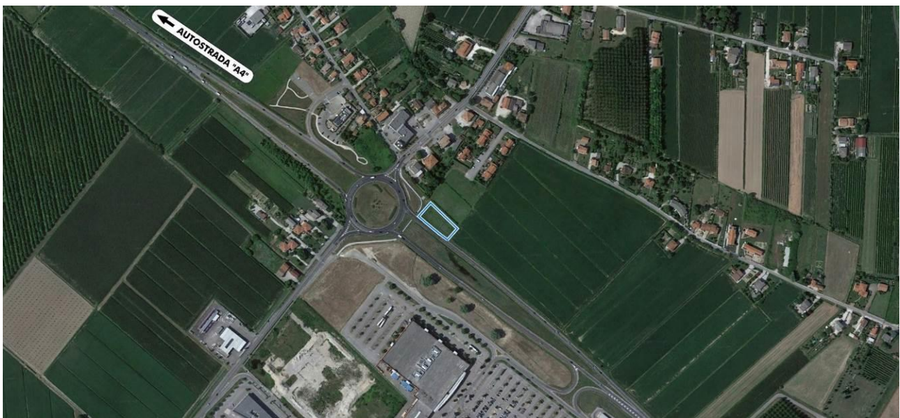
FIGURA 4-24 FOTOPIANO CON INDIVIDUAZIONE DEL CANTIERE OPERATIVO 2-D1
