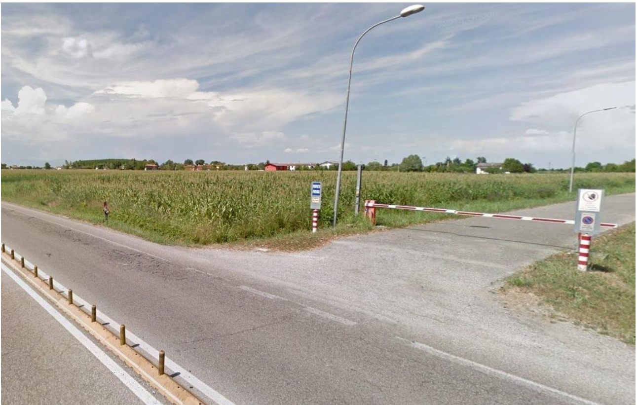
FIGURA 2-36 RIPRESA FOTOGRAFICA DA TERRA DELL'AREA DI CANTIERE AO
