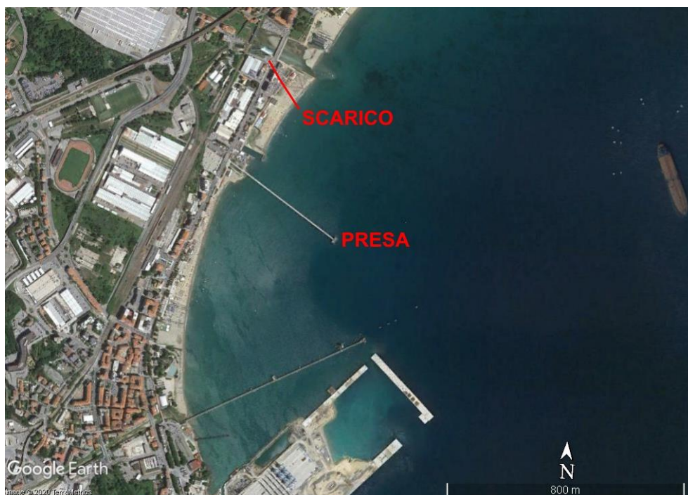
Figura 4-1 Localizzazione delle opere di presa e di scarico della centrale termoelettrica Vado Ligure
