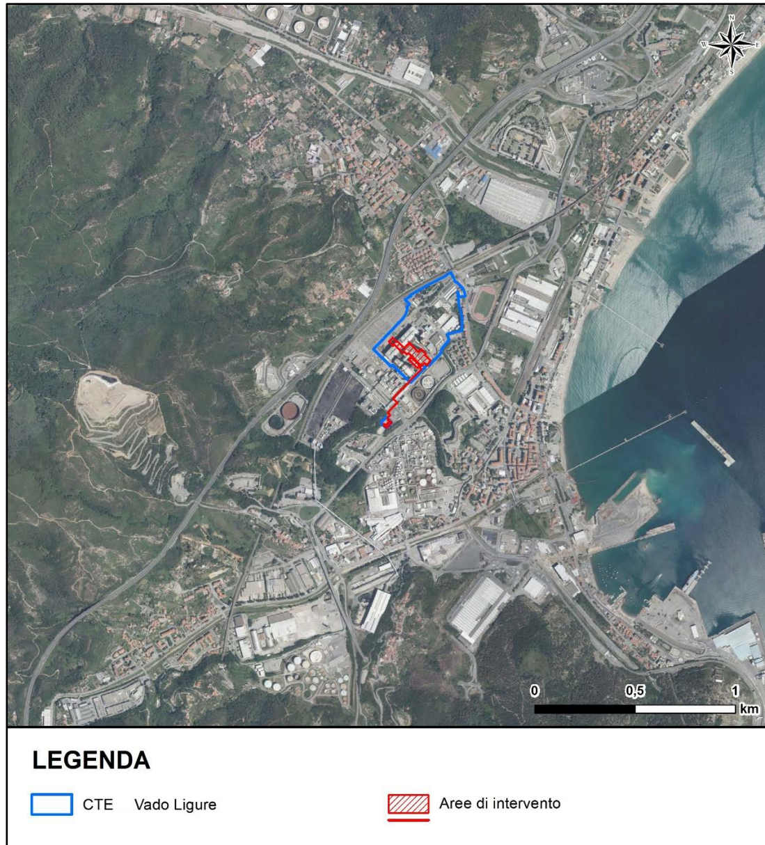
Figura 3.1a Localizzazione della Centrale Termoelettrica Vado Ligure
