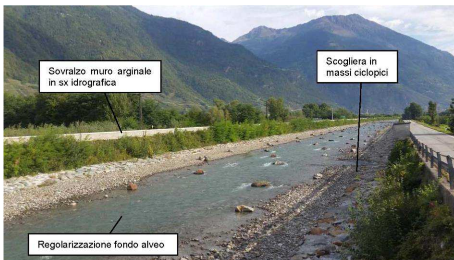
Figura 13.1: Stato attuale del tratto di fiume Adda sottoposto agli interventi AIPo
