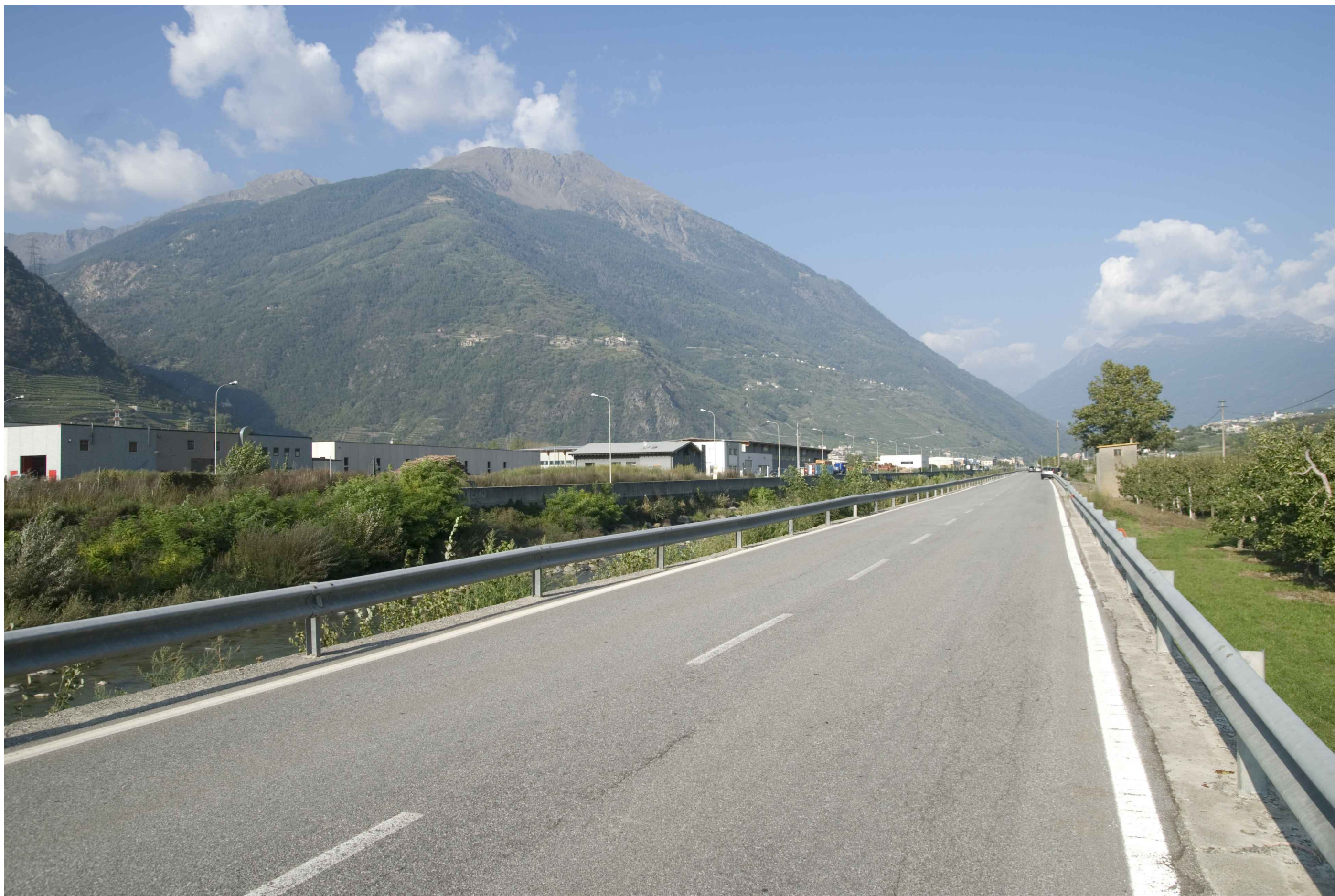
PONTE SULL'ADDA PRESSO ZONA INDUSTRIALE DI TIRANO Situazione attuale
