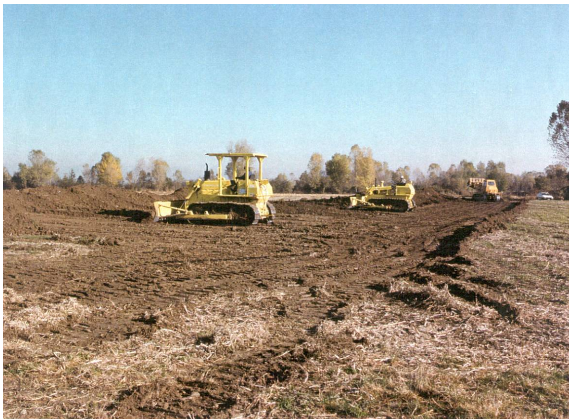
Foto 4.1/B: Apertura dell'area di passaggio
