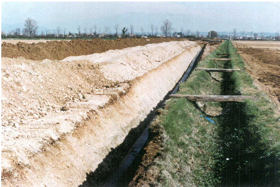
Foto 4.1/G: Tratto di condotta posata, si nota l'accantonamento dello strato humico separato dal materiale di scavo della trincea
