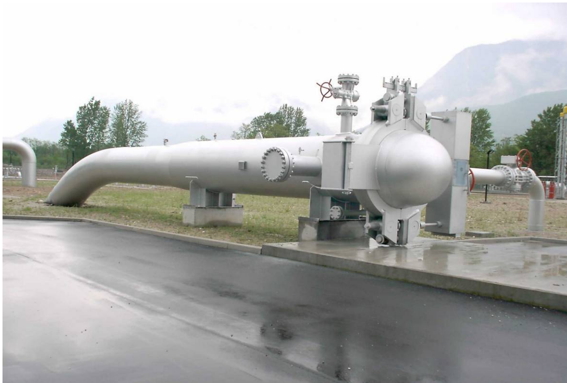
Foto 3.2/A: Punto di lancio e ricevimento pig
