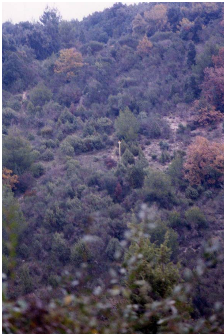
Foto 8/C: Lavori di costruzione terminati circa 30 anni fa - il tracciato del metanodotto è difficilmente individuabile. La vegetazione ha ormai ricoperto tutto il versante.
