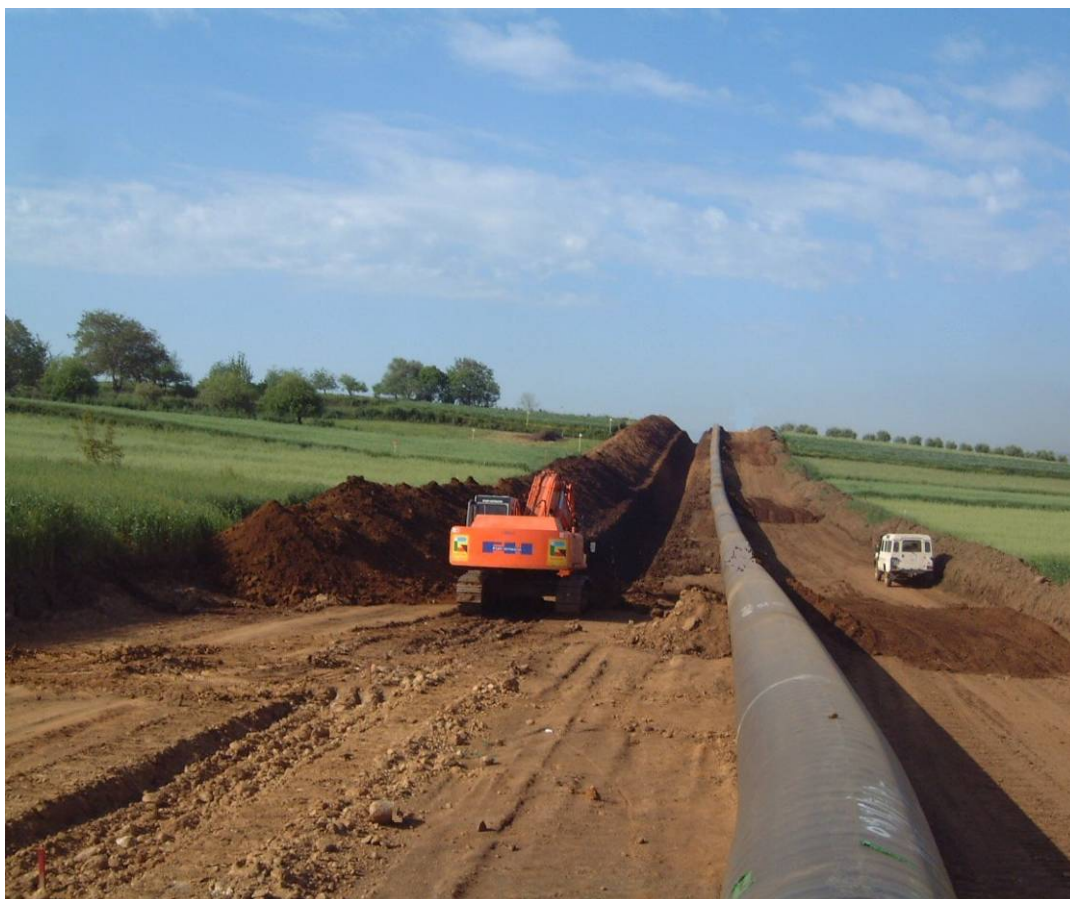
Foto 4.1/E: Scavo della trincea
