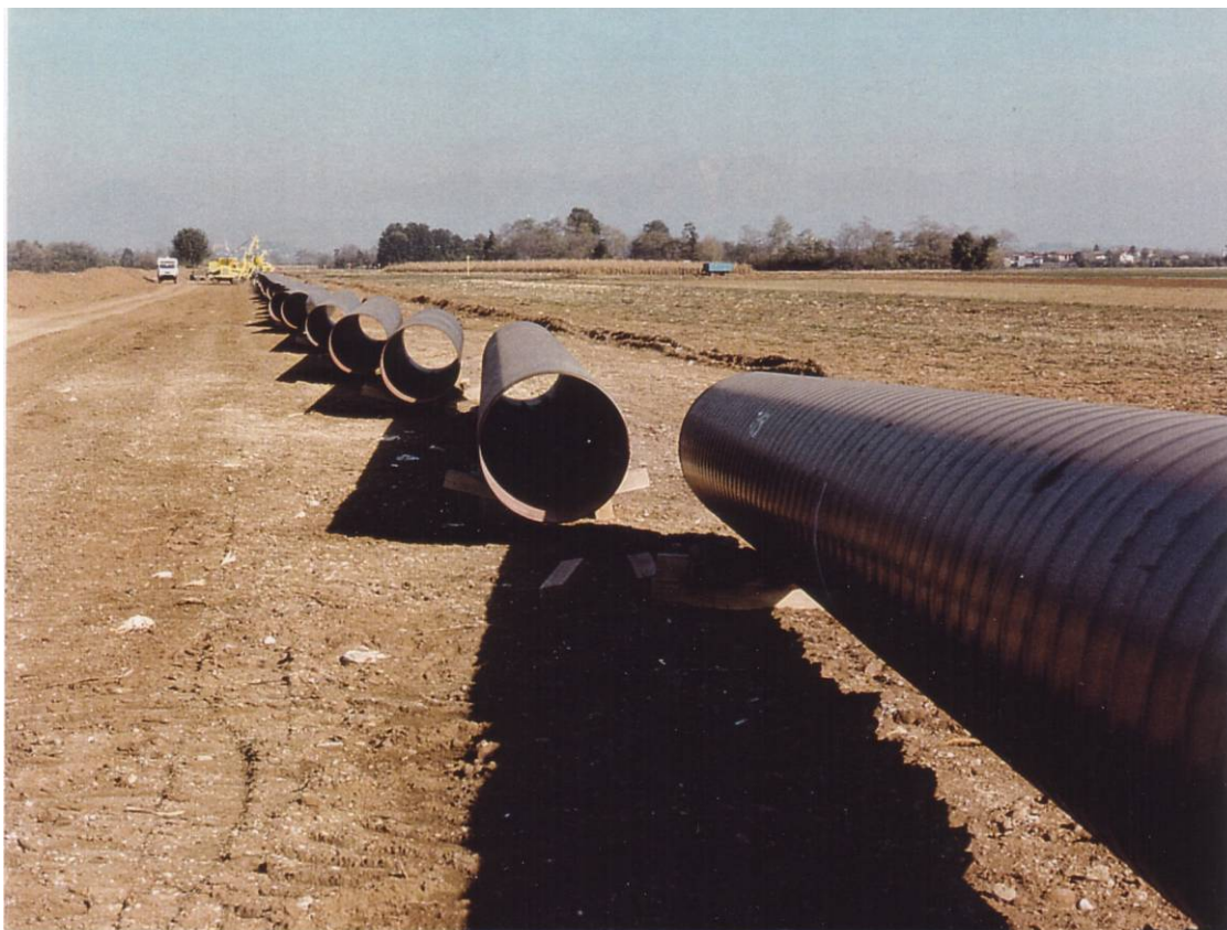
Foto 4.1/C: Sfilamento tubazioni
