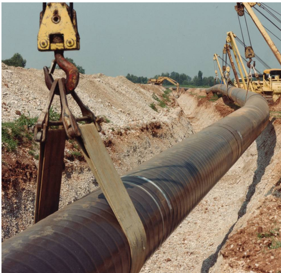
Foto 4.1/F: Posa della condotta
