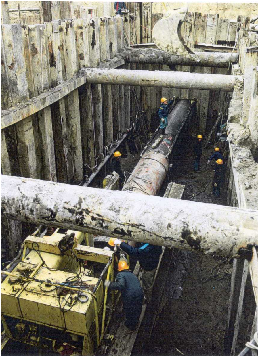
Foto 4.1/L: Trivellazione con spingitubo
