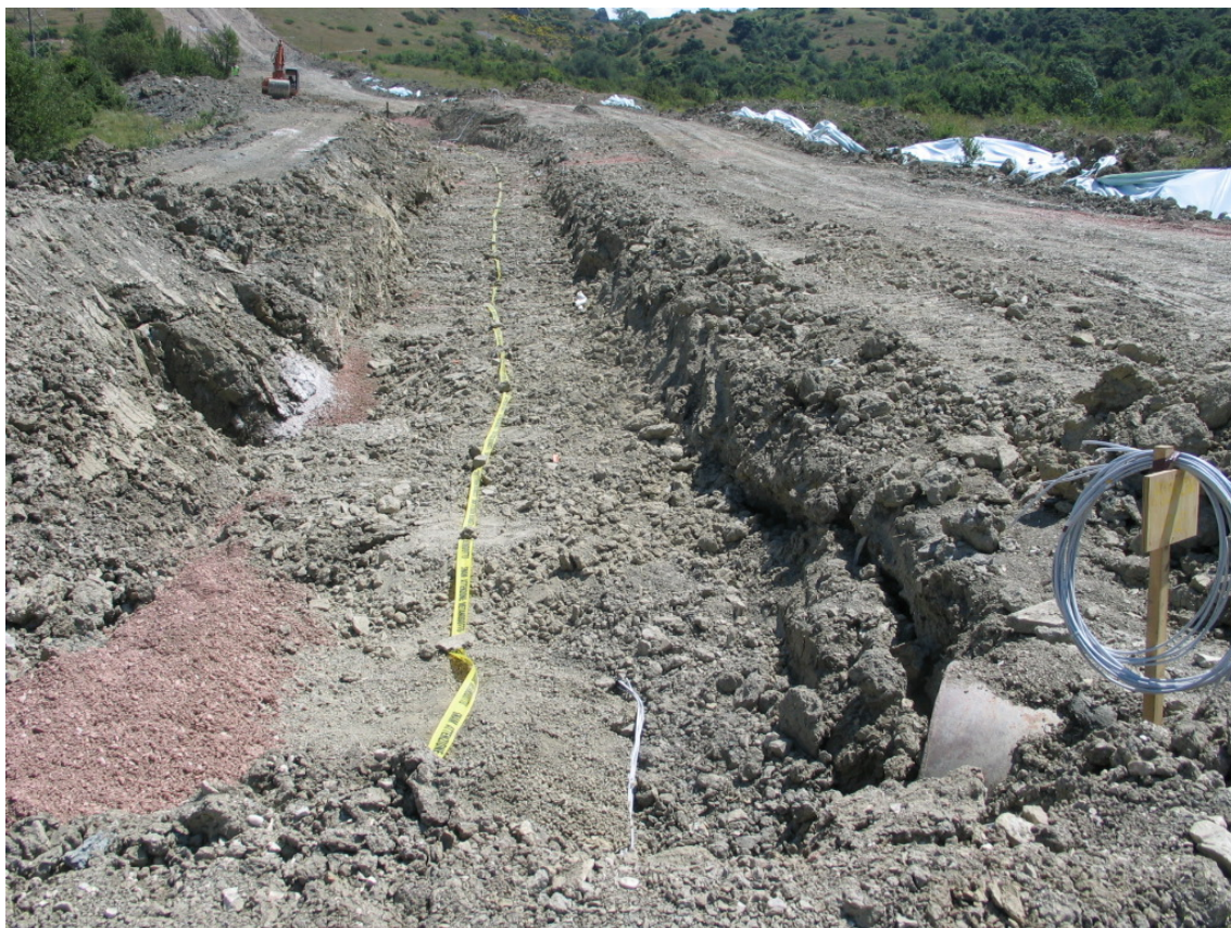
Foto 4.1/H: Rinterro della condotta
