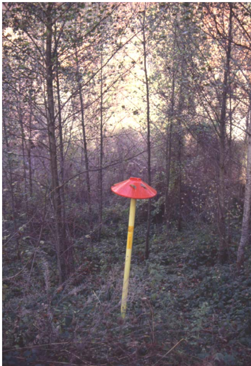
Foto 8/A: Metanodotto realizzato nel 1980 - rivegetazione naturale del tracciato del metanodotto (non sono stati eseguiti ripristini). Le paline sono totalmente nascoste dalla vegetazione.
