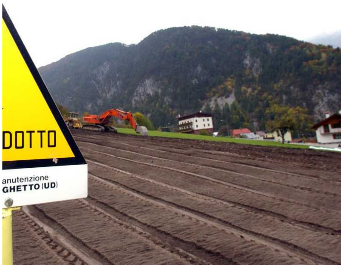
Foto 4.1/I: Ridistribuzione dello strato humico superficiale
