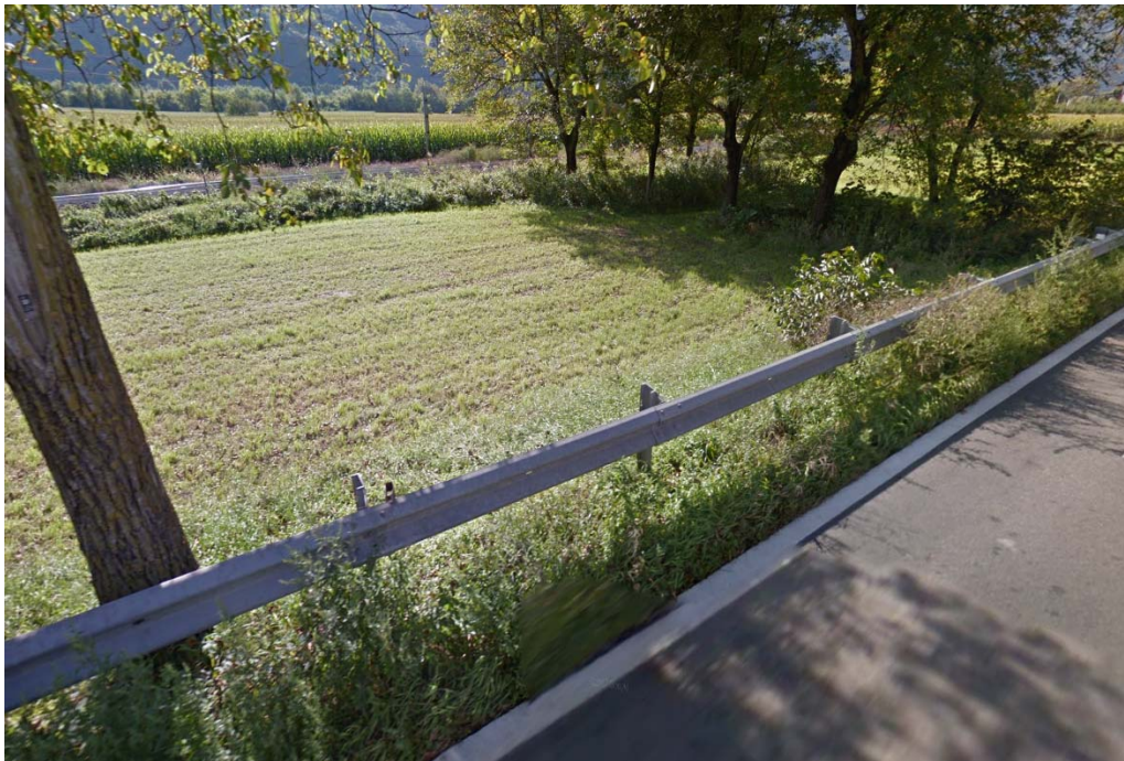
Barriera esistente (Marcegaglia) in corrispondenza dell'innesto della variante a sud
