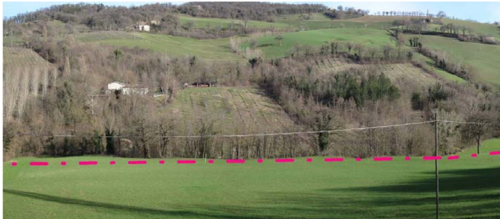
Foto 29: Area 27(F-16-0679). Il metanodotto attraversa una superficie terrazzata in sponda sinistra; l'accumulo di frana principale è situato in sponda destra.
