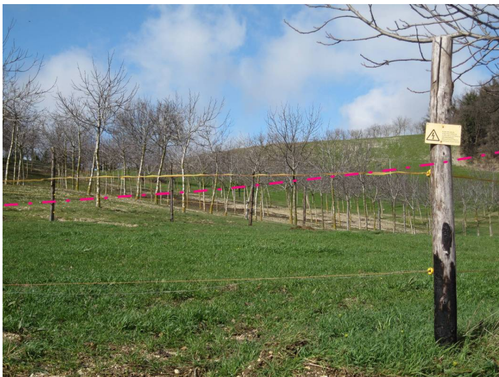
Foto 34: Aree 32 e 33 (F-12-1424). Parte superiore del corpo di frana sul fianco destro.
