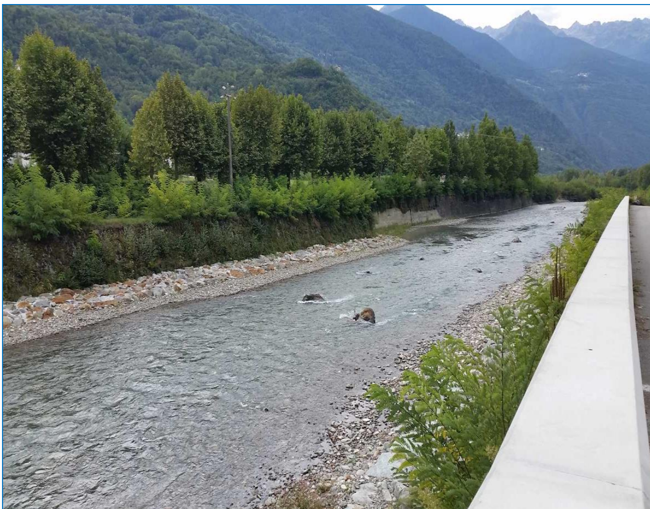
Figura 6.12 – vista verso valle del tratto a valle del ponte esistente di Stazzona
