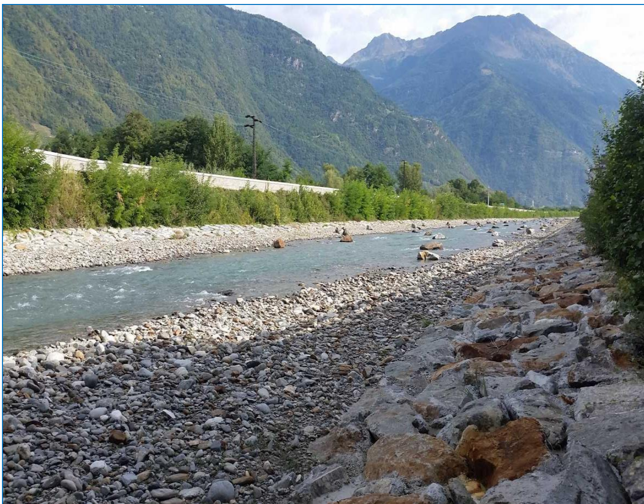
Figura 6.10 - vista verso monte del tratto a monte del ponte esistente di Stazzona
