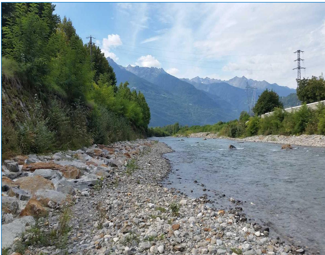
Figura 6.11 - vista verso valle da sotto il ponte esistente di Stazzona
