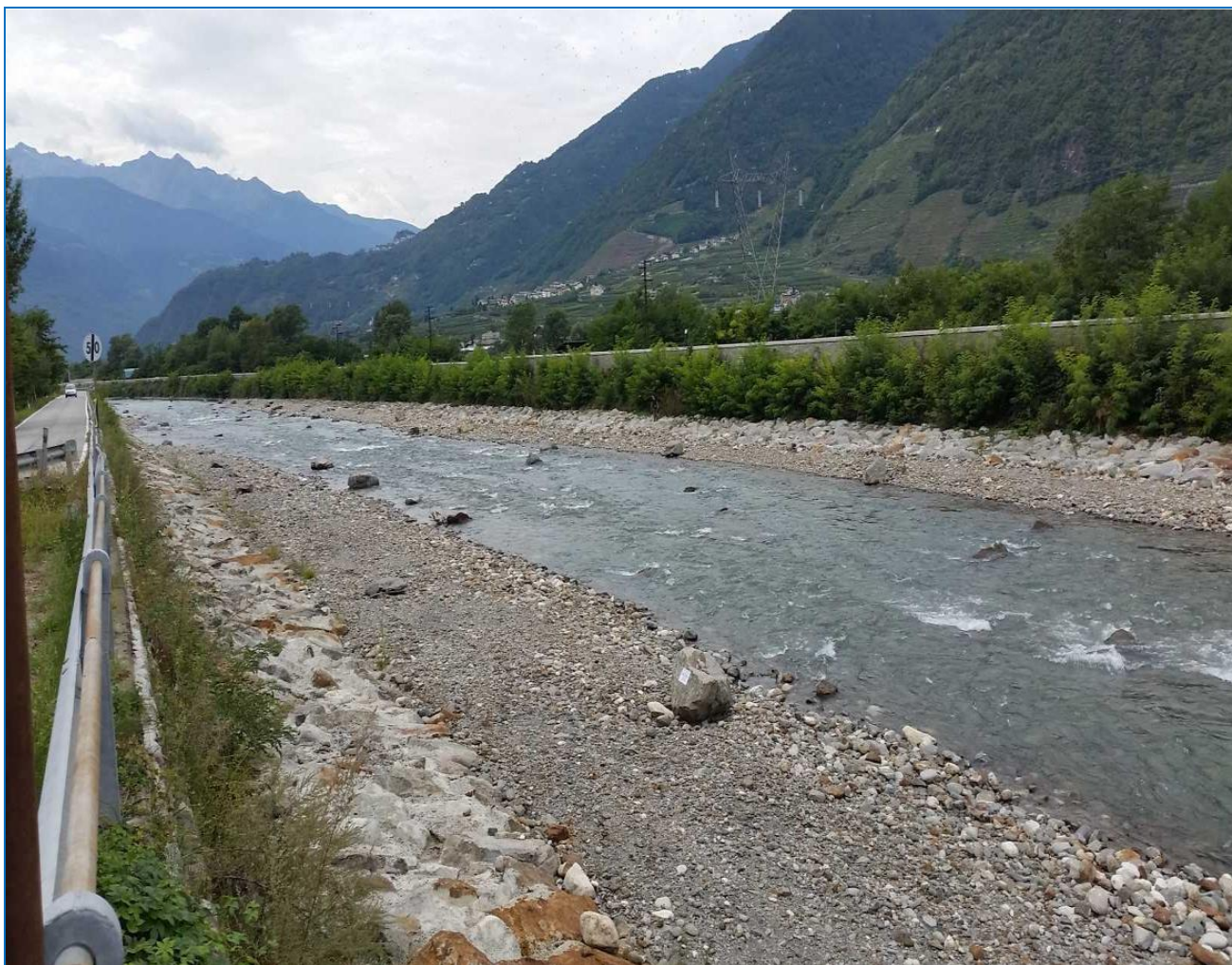
Figura 6.8 - vista verso valle del tratto compreso tra la confluenza del Poschiavino e il ponte esistente di Stazzona
