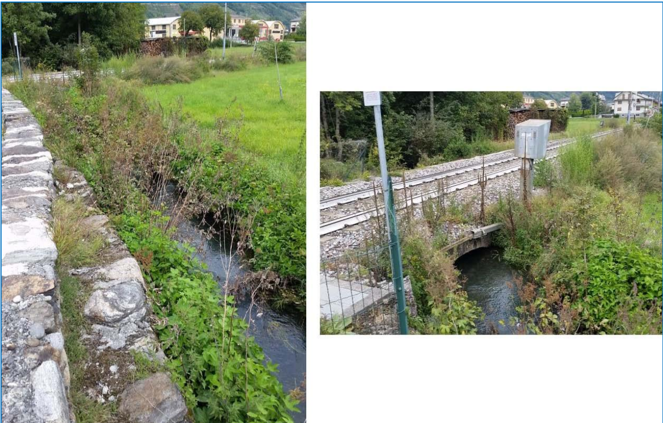
Figura 6.1.1: canale Rossi a monte dell'attraversamento ferroviario
