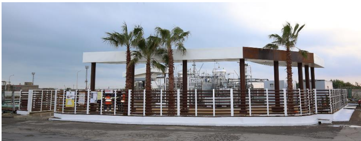
Figura 3-5: Vista recinzione in acciaio Cor-Ten attualmente installata presso l'impianto FORSU all'interno della Raffineria di Gela
