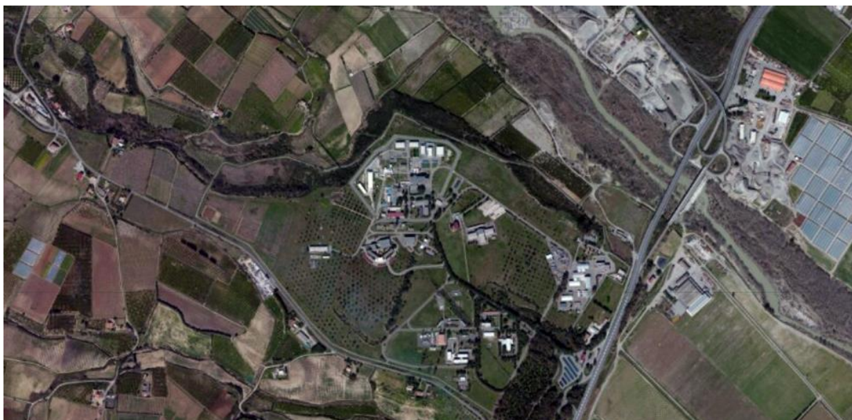
Figura 2.1-8: Impianto ITREC - Rotondella
