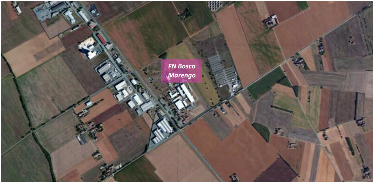
Figura 2.1-5: Impianto FN di Bosco Marengo
