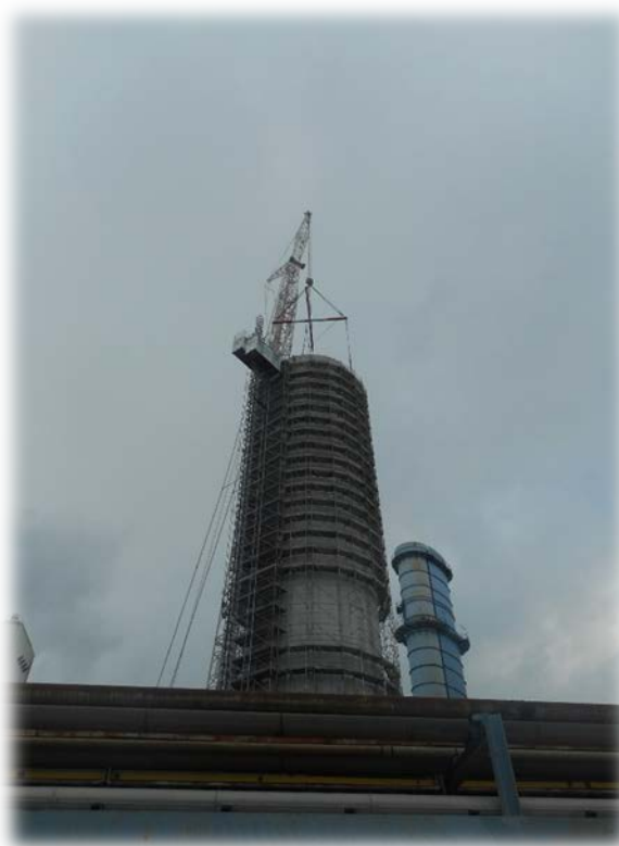
Esempio Ponteggi perimetrali
