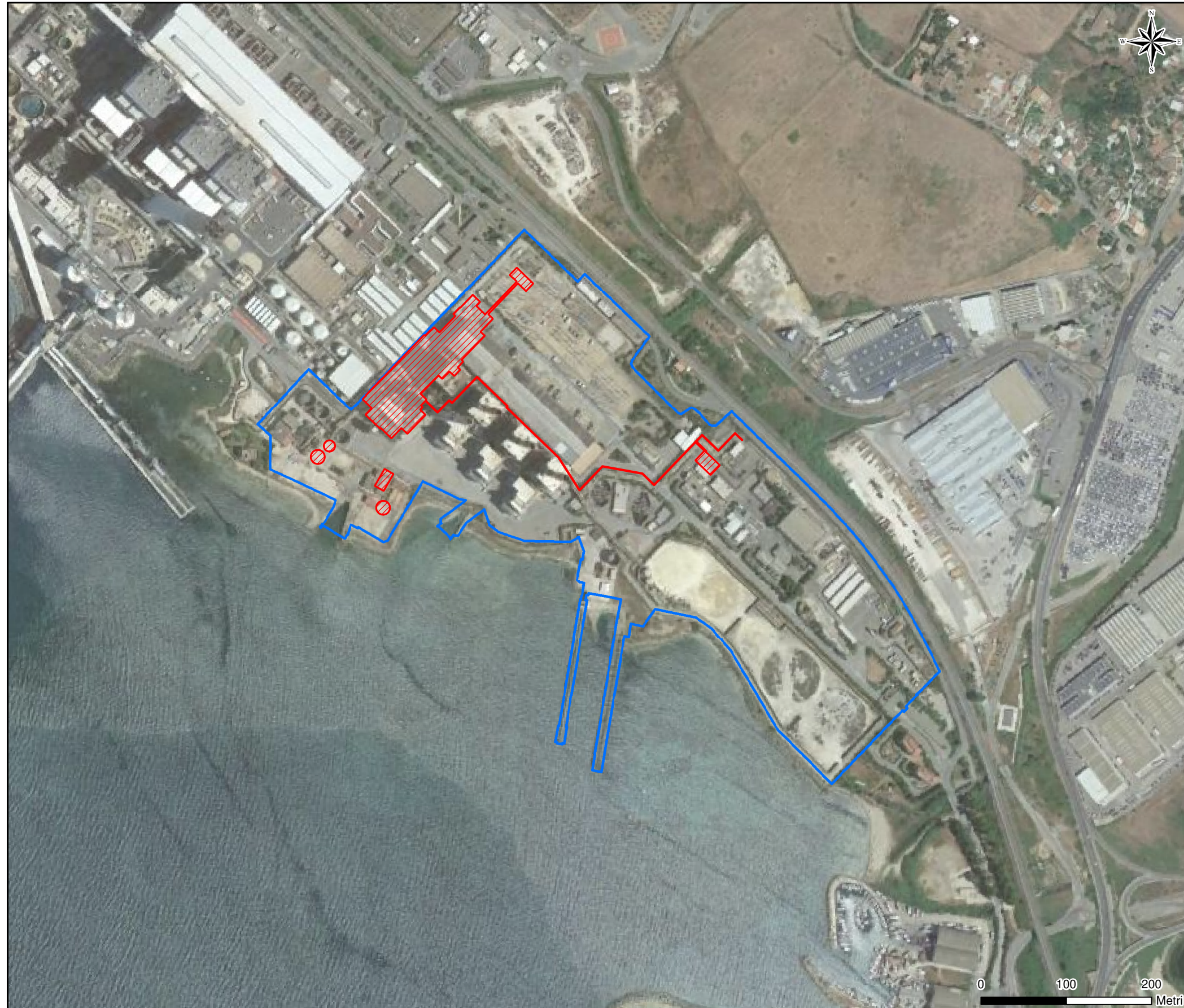
Figura 1a Localizzazione Centrale Torrevaldaliga Sud su immagine satellitare (Scala 1:5.000)
