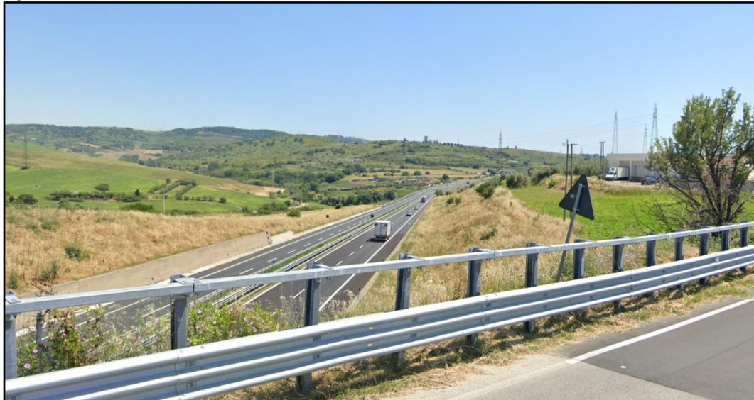
Una volta lasciatisi alle spalle l'edificato di Civitavecchia, l'Aurelia assume le caratteristiche di una strada extraurbana principale, senza intersezioni a raso e con banchine laterali, creano di fatto insieme all'Autostrada una rilevante barriera fisica all'interno del territorio attraversato.
