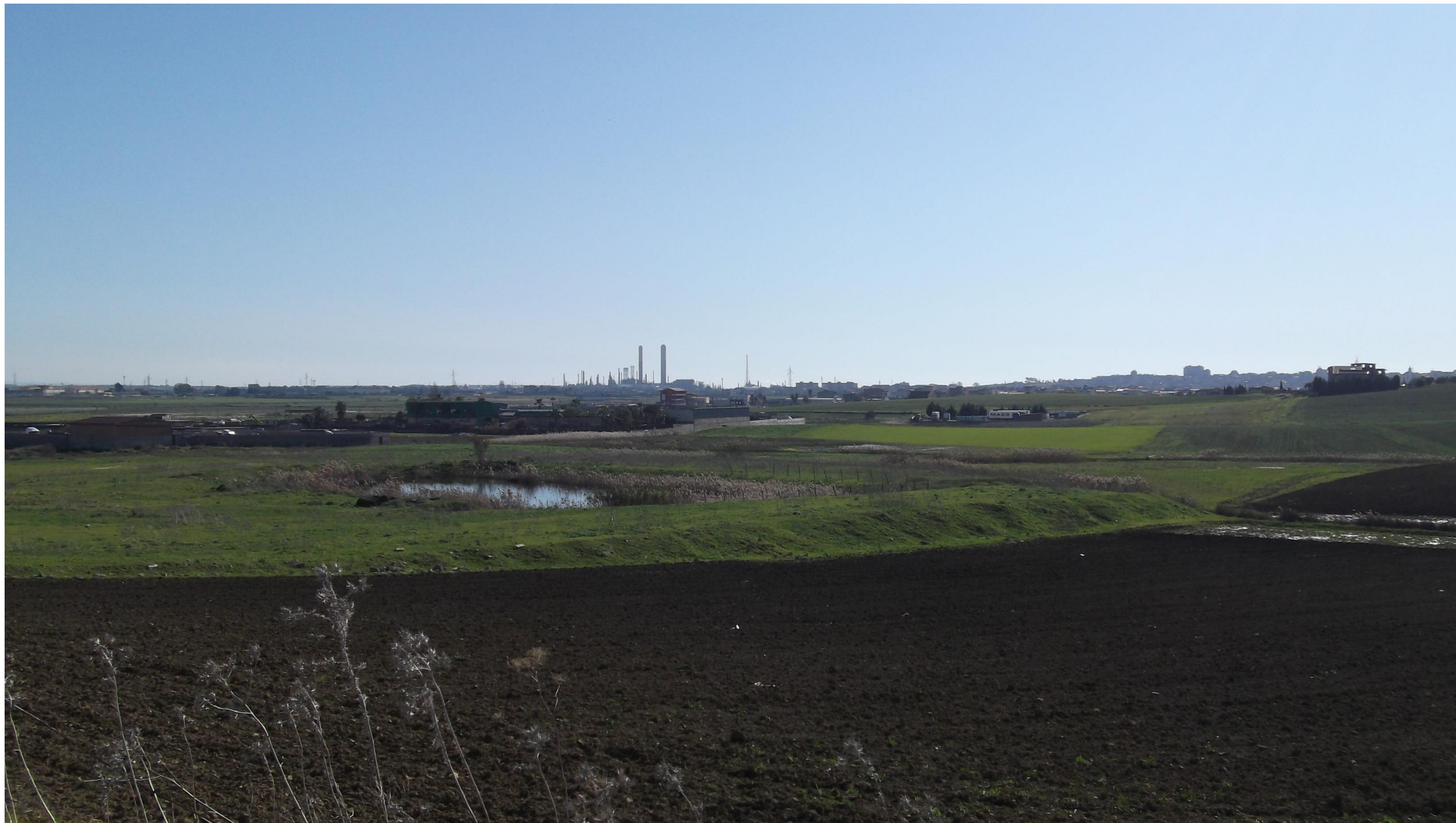
Punto 14: Vista in direzione Sud da una strada vicinale, situata a Nord del centro abitato di Gela. Nell'area inquadrata la SS 554 sarà realizzata per un tratto in rilevato e proseguendo verso Est sarà realizzato un viadotto per l'attraversamento della SP 81 (fonte: Sopralluogo VDP)
