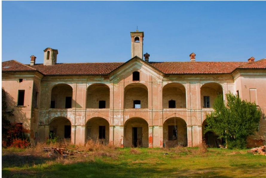
Figura 4.7.10 – Vista del fronte principale della cascina
