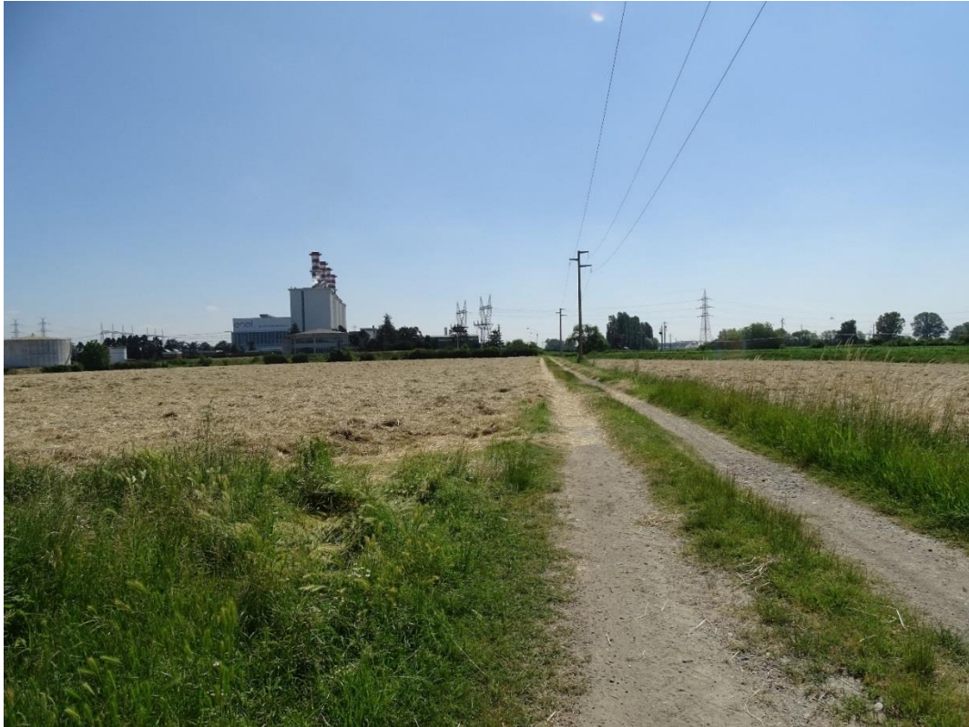
Figura 4.7.24 – Punto di vista 5 – stato di fatto
