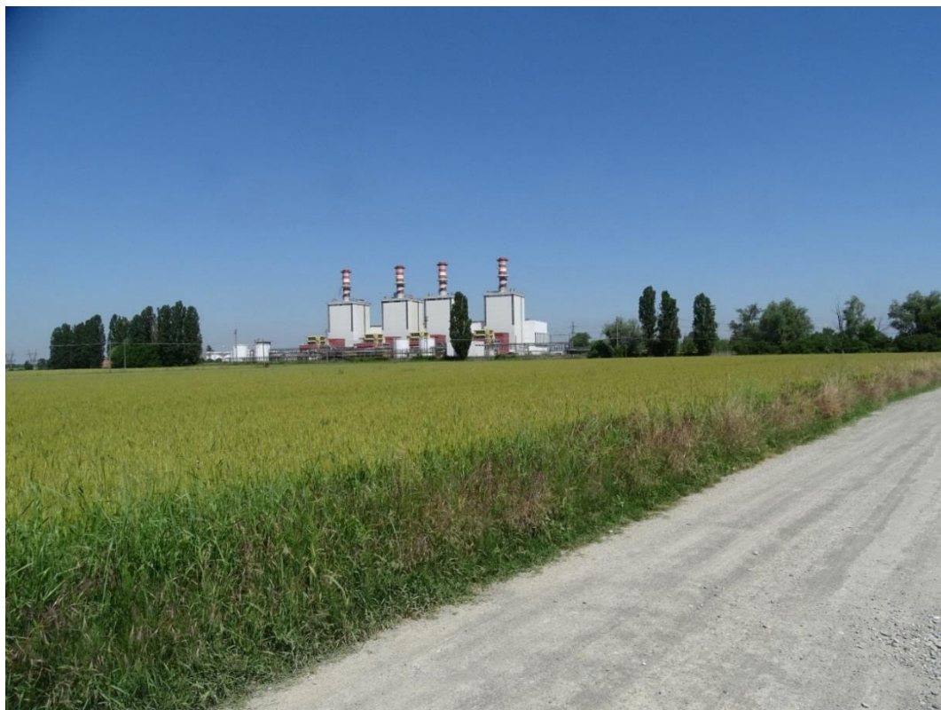
Figura 4.7.26 – Punto di vista 6 – stato di fatto
