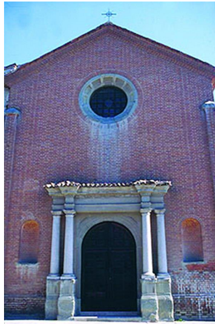
Figura 4.7.6 – Vista dell'esterno della chiesetta
