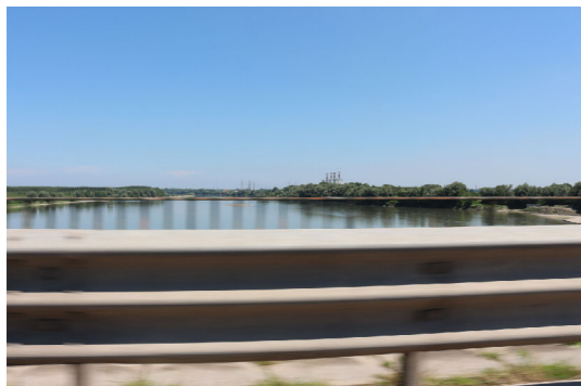
02: dalla SP 412, all'altezza del ponte sul Po
