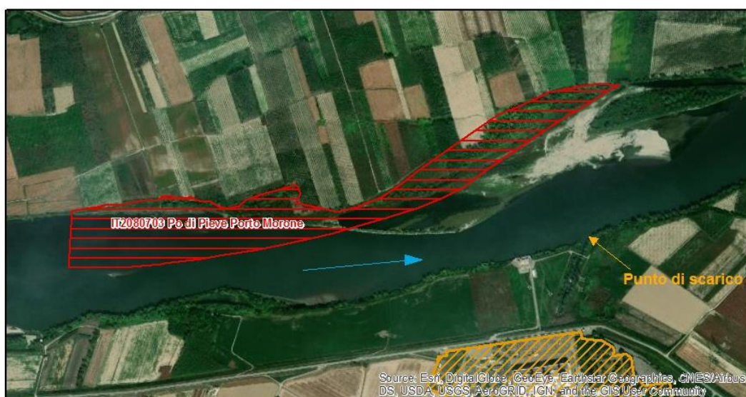
Figura 8.2.1 – Localizzazione del punto di scarico della centrale rispetto alla ZPS IT2080703
