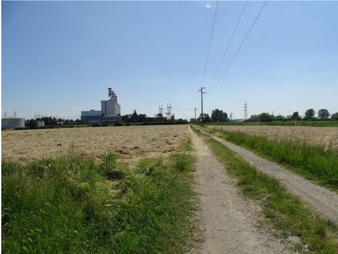
Figura 5.4.9 – Punto di vista 5 – stato di fatto
