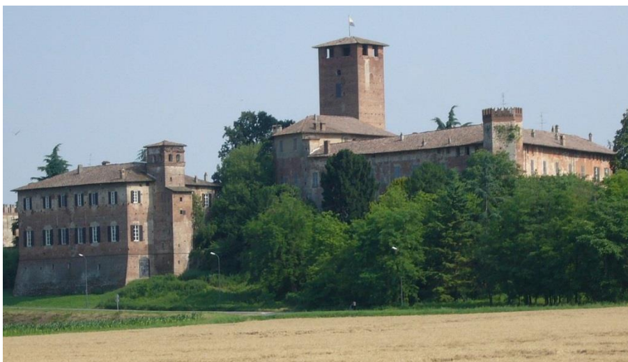
Figura 4.4.6 – Castello di Sarmato
