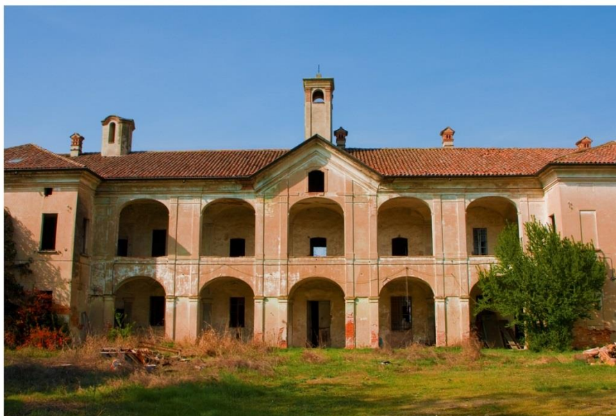
Figura 4.4.8 – Vista del fronte principale della cascina
