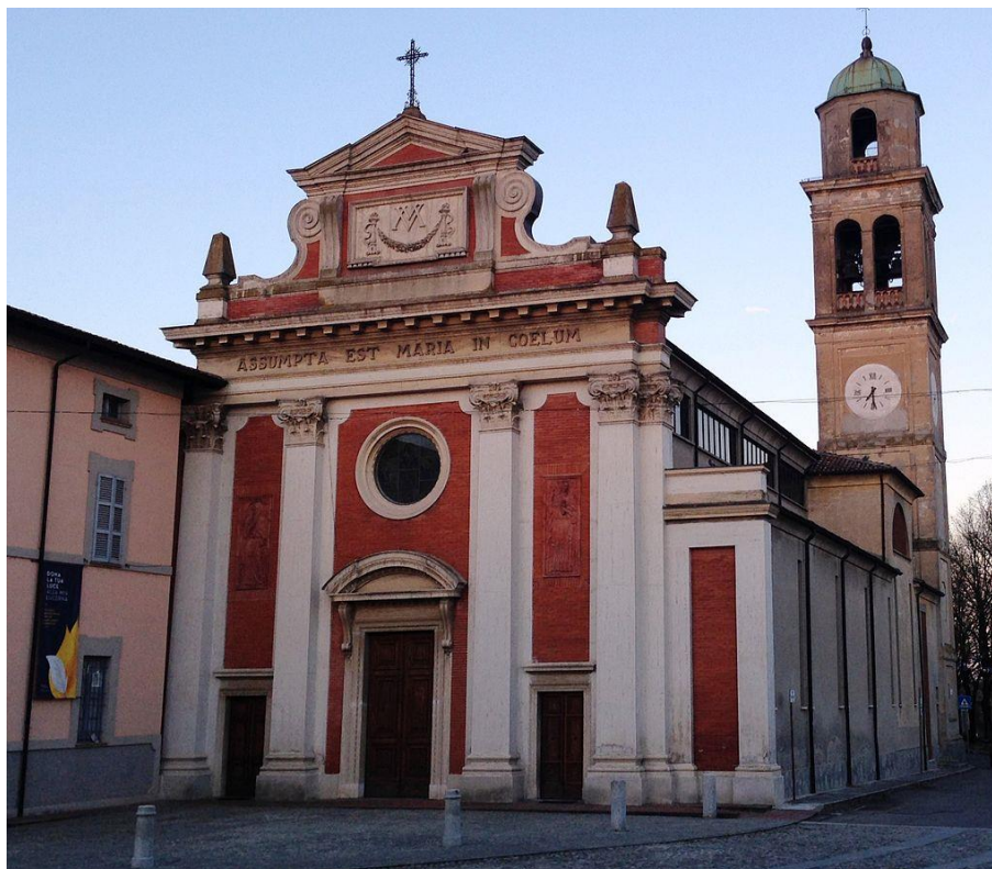
Figura 4.4.5 – Vista dell'esterno della chiesa di Santa Maria Assunta
