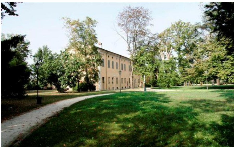
Figura 4.4.3 – Vista dell'esterno della Villa Braghieri
