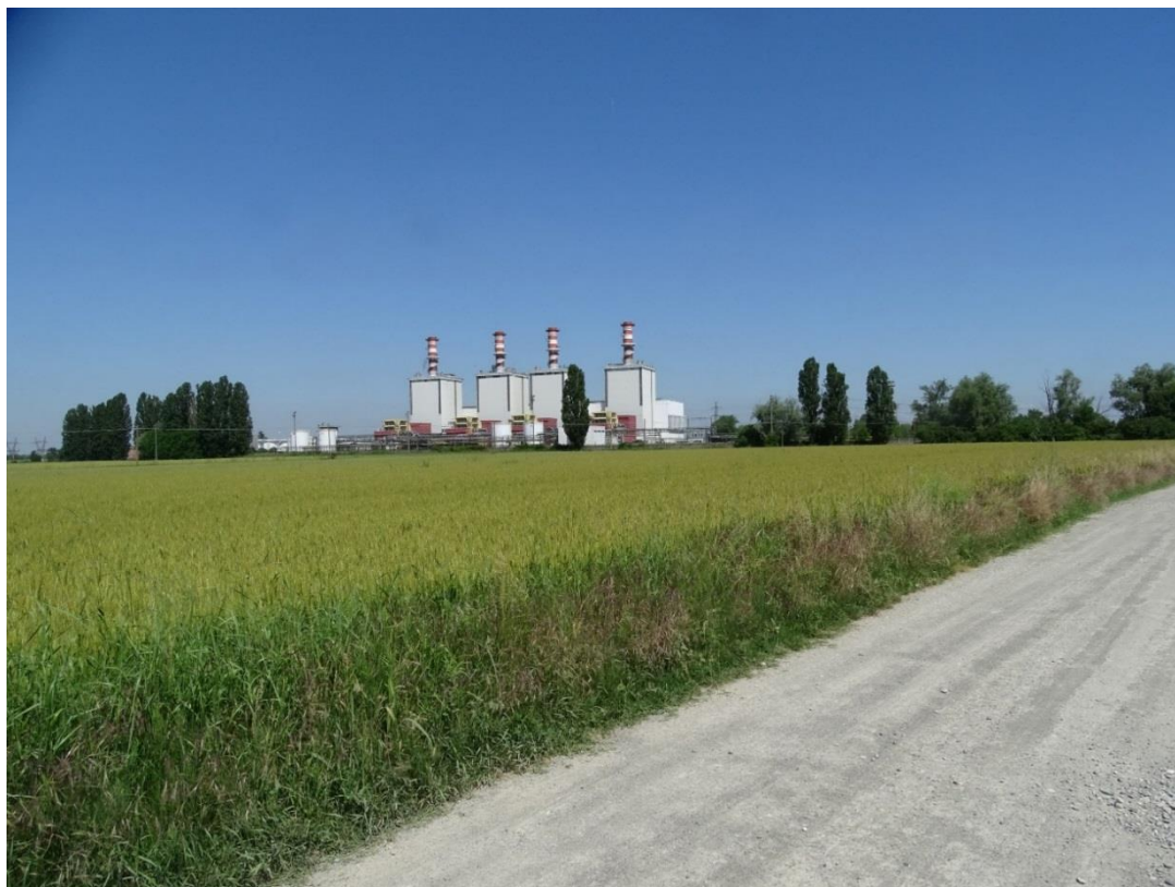
Figura 5.4.11 – Punto di vista 6 – stato di fatto
