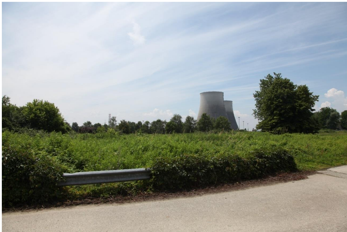
Figura 4.7.15 – Punto di vista 2 – stato di fatto
