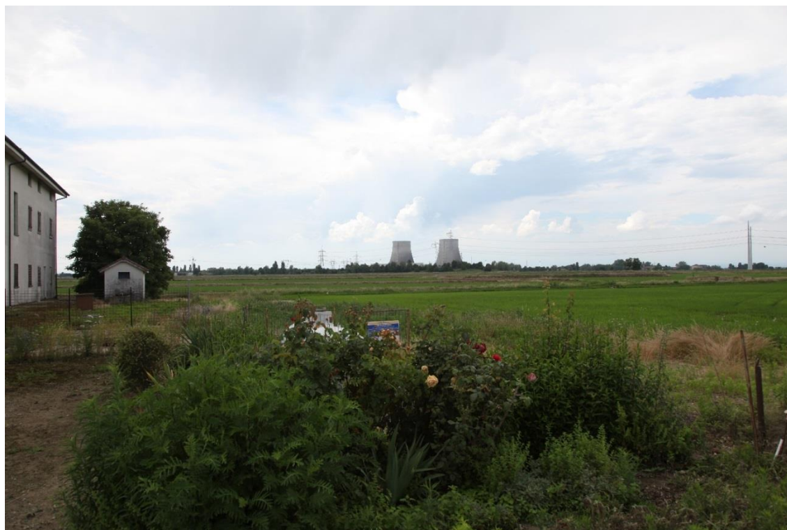
Figura 4.7.31 – Punto di vista 10 – stato di fatto
