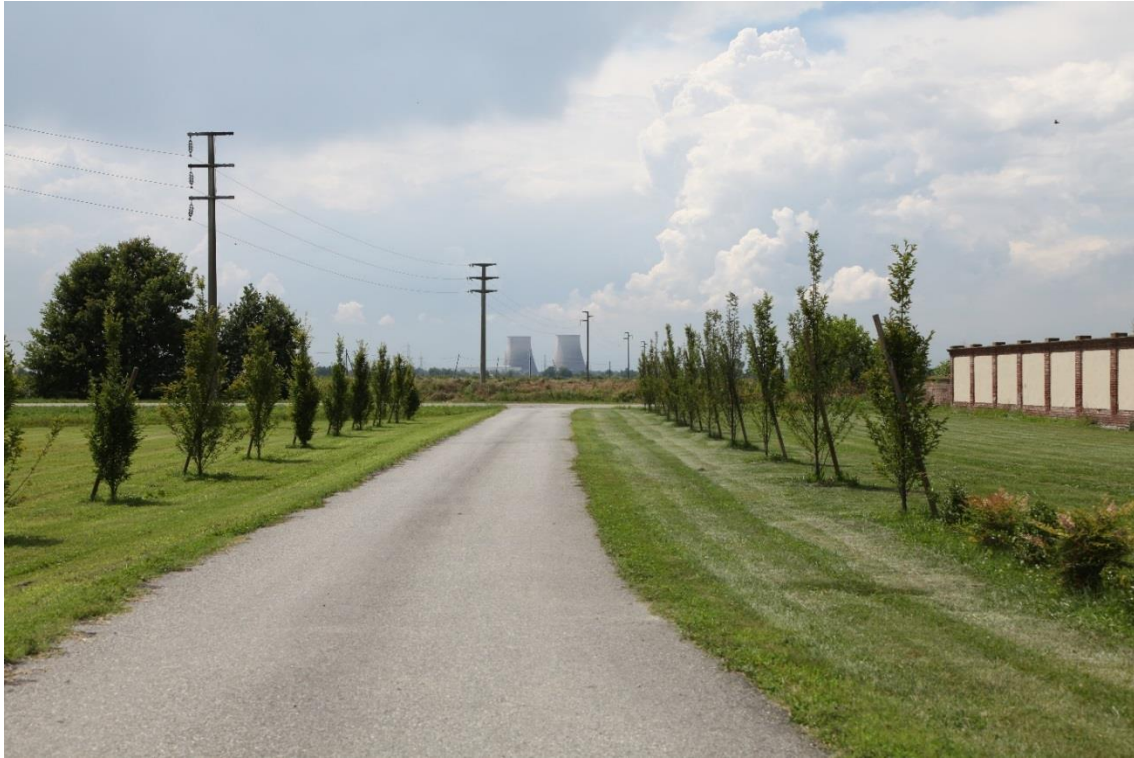
Figura 4.7.33 – Punto di vista 11 – stato di fatto
