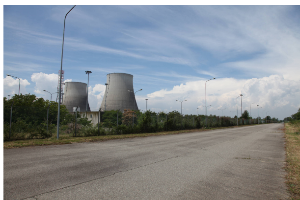
04 - dalla strada che conduce all'ingresso della centrale
