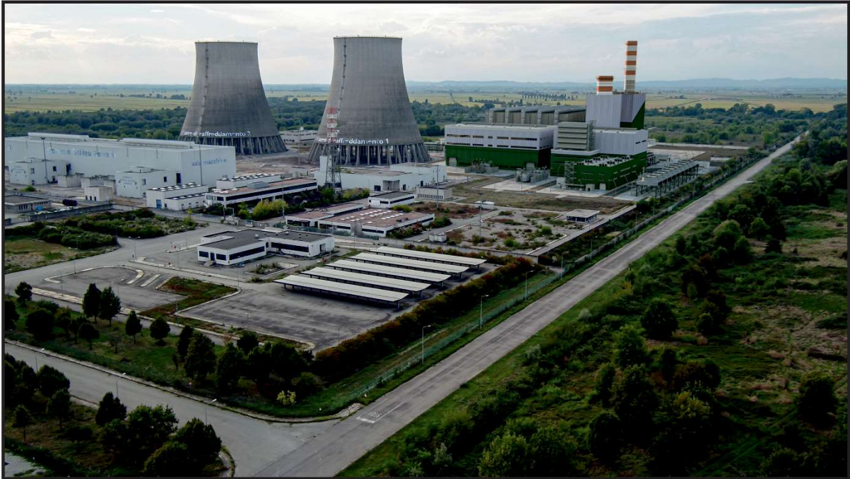
TRINO VERCELLESE (VC) - CENTRALE ENEL - - STATO FUTURO - VISTA I
