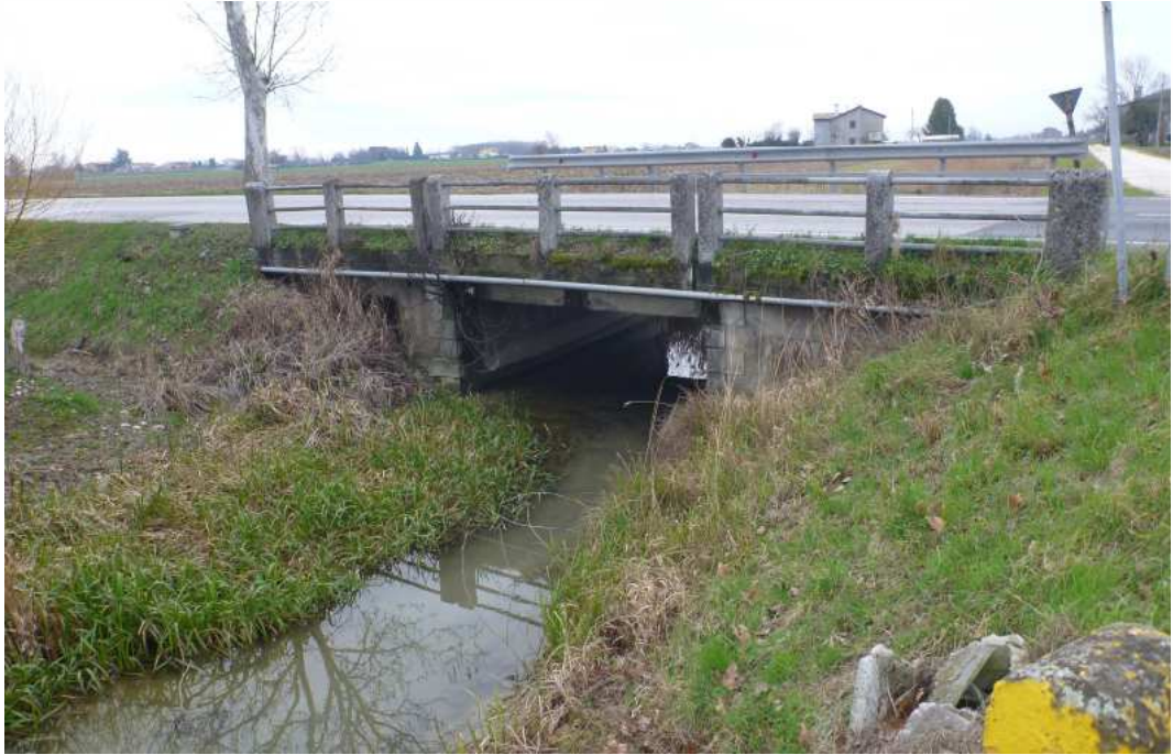
Figura 5.5 - Attraversamento del canale Caposile, ponte su via Armellina immediatamente a valle dell'immissione del canale Bosco.
