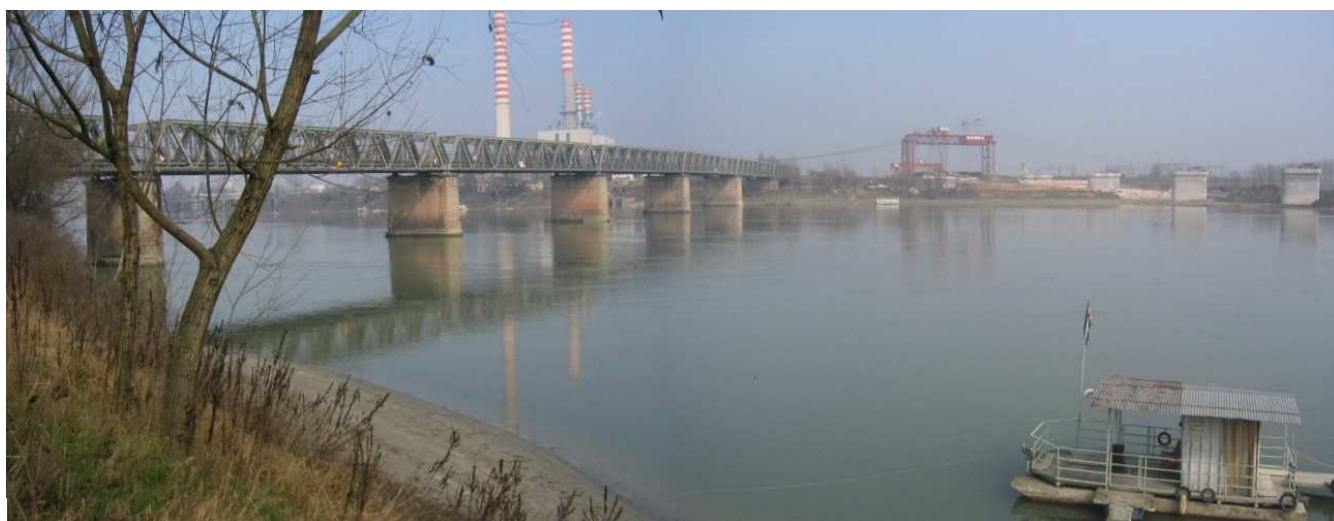
Figura 4.3.3/8 – Vista d'insieme delle pile dei due ponti a valle dello scarico
