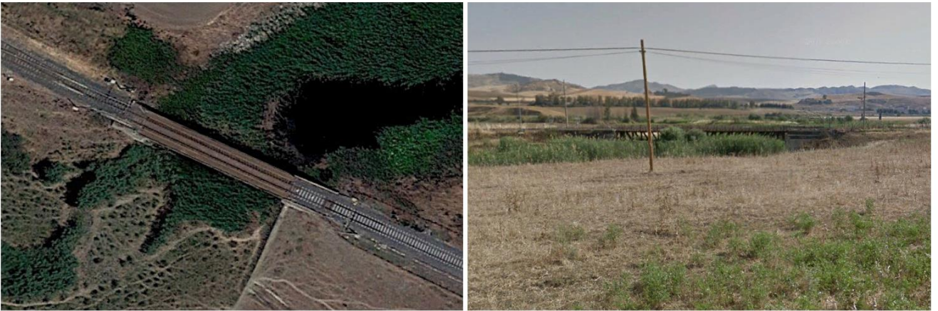
Figura 5 – Torrente Calderari: foto dell’attraversamento esistente.
