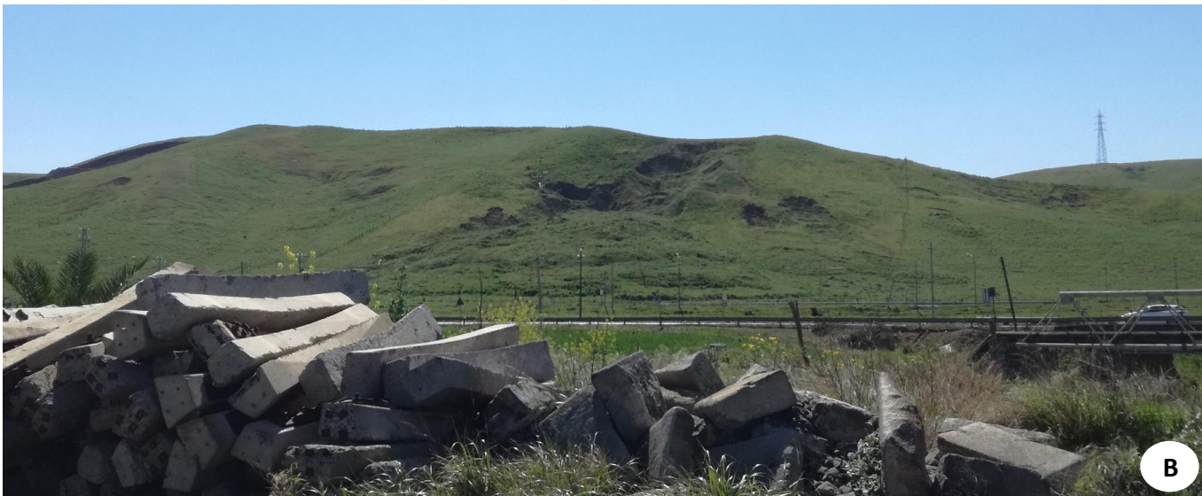
Figura 25. Esempio di instabilità su versante in argilla di Terravecchia nei pressi della stazione di Dittaino, poco oltre i limiti dell'area di studio
