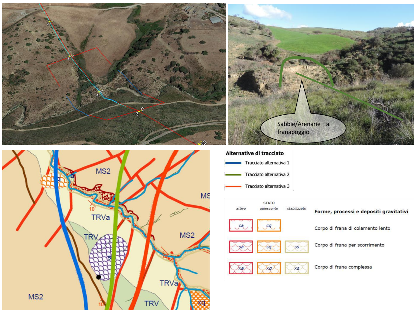
Figura 4. Immagine di google earth dell’imbocco “Galleria Sicani” lato Palermo. Alternativa di tracciato 2; a destra foto dell’imbocco con evidenti problematiche di erosione al piede e piccoli dissesti. In basso stralcio cartografico con riportate le tre alternative di tracciato; si nota la presenza di dissesti ed aree in erosione per le alternative 1 e 2.
