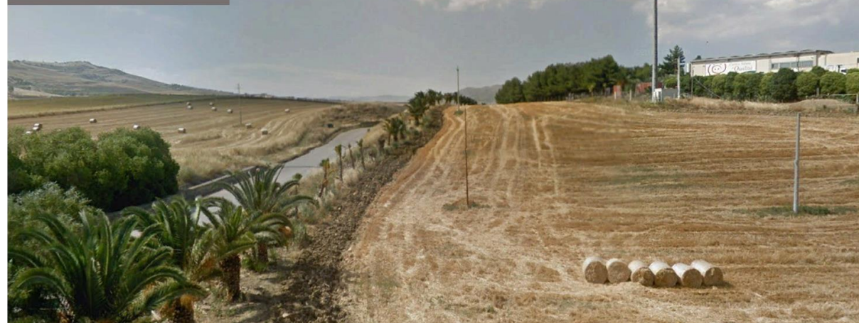
Figura 4-17 Visuali del viadotto VI02 dalla autostrada A19
