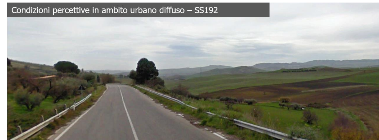
Figura 4-7 Condizioni percettive in ambito dell'abitato diffuso
