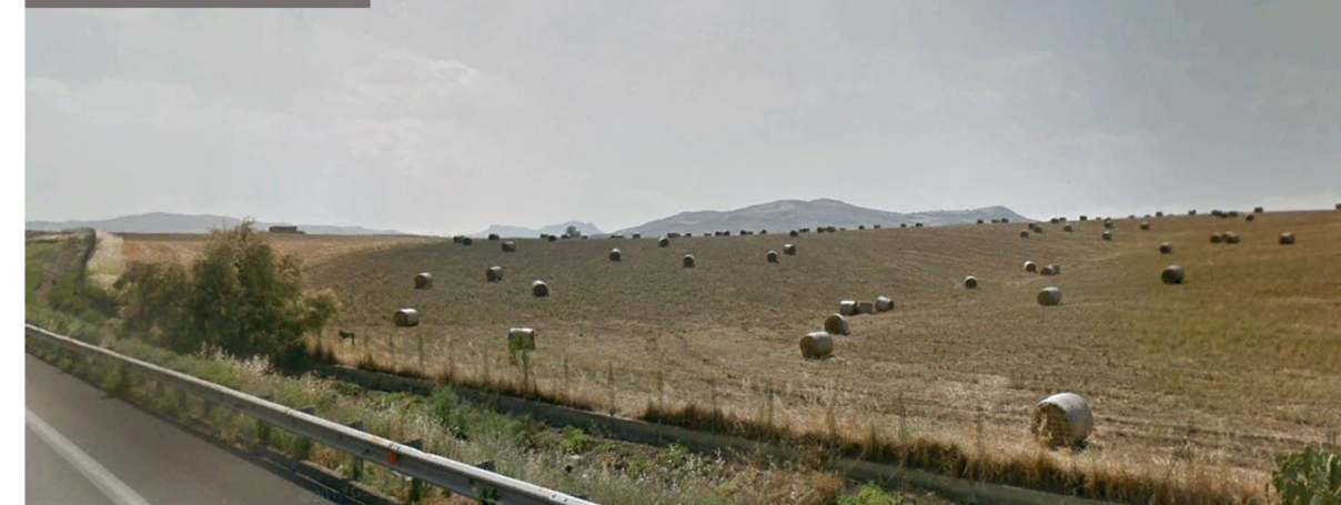
Figura 4-18 Visuali del viadotto VI03 dalla autostrada A19
