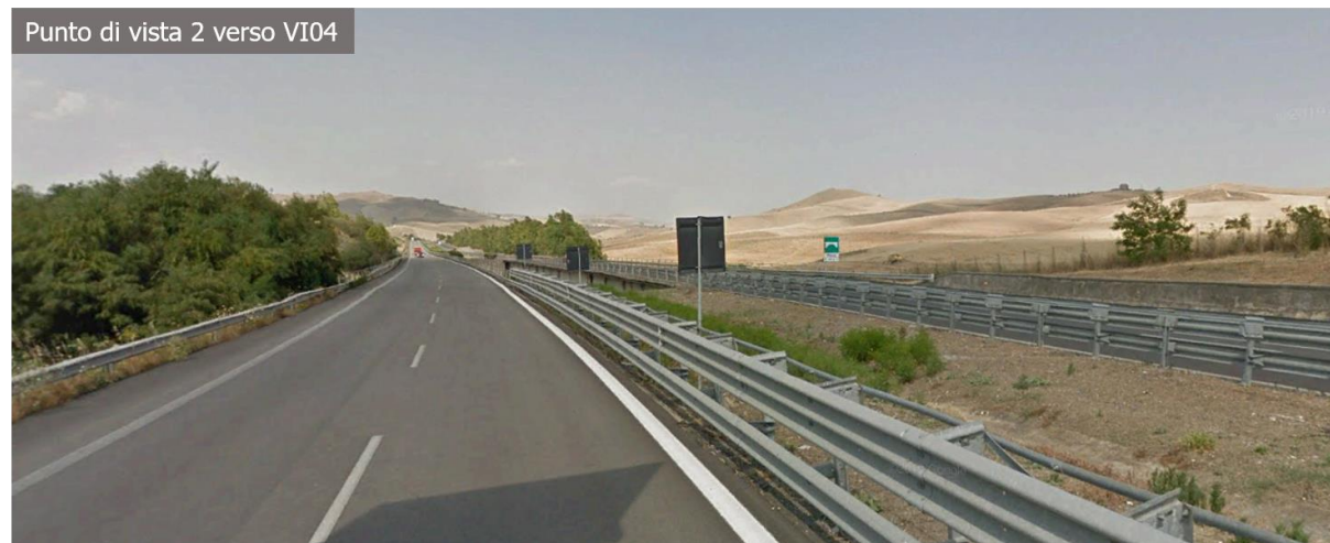
Figura 4-19 Visuali del viadotto VI04 dalla autostrada A19
