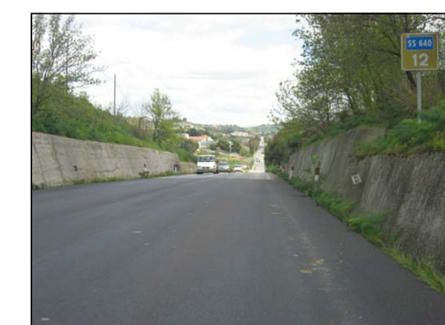
Non si evidenziano particolari anomalie sul manto stradale
