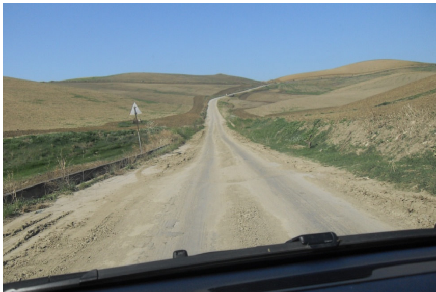
Tratti di viabilità che possono presentare fanghiglia sulla sede stradale
