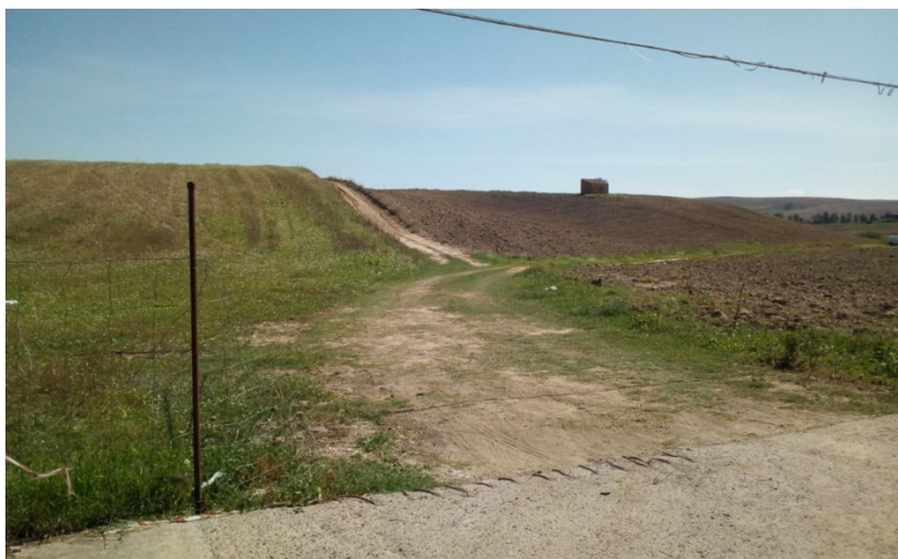
Origine della pista di cantiere per le opere fra la SP7A e l'autostrada A19
