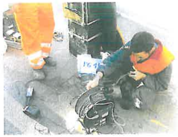
Foto 2 : Esecuzione indagine videoendoscopica
