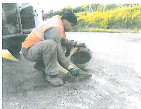
Foto 2 : Ripristino foro di ispezione
