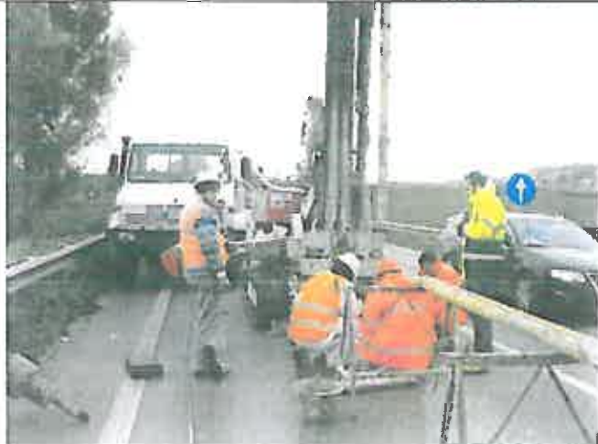
Foto 5 – Sondaggio PG3 Postazione di sondaggio
