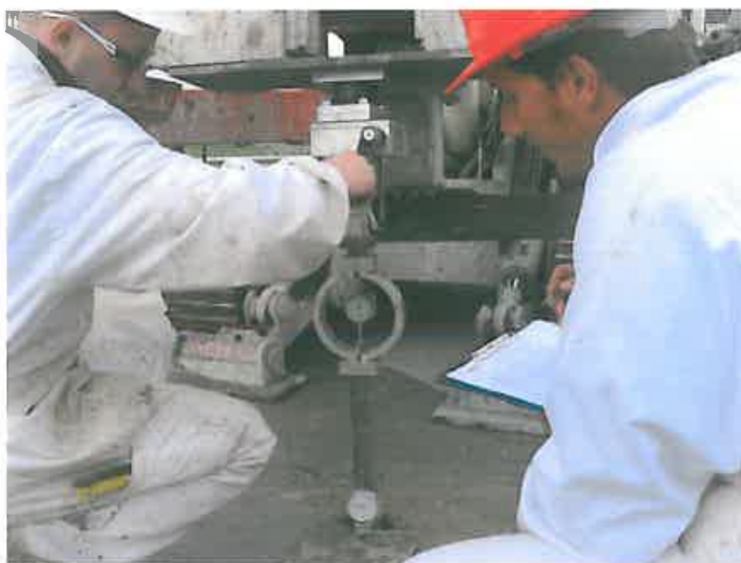
Fig.4 - Prova CBR in situ
