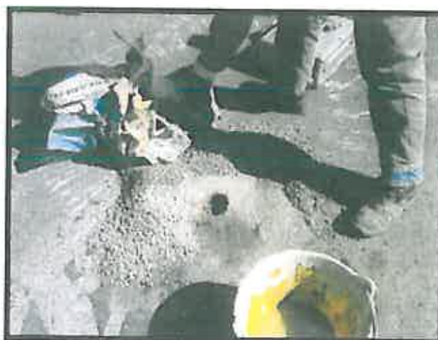
Figura 8: Fase di riempimento del foro di sondaggio
