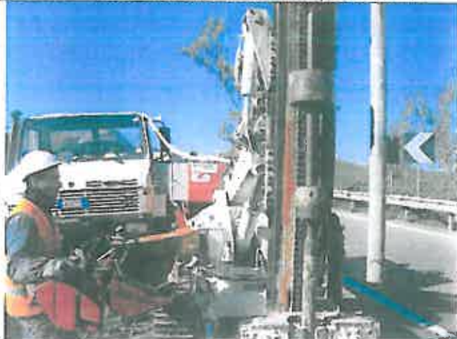
Foto 41 – Fase di lavoro: esecuzione prova S.P.T.
