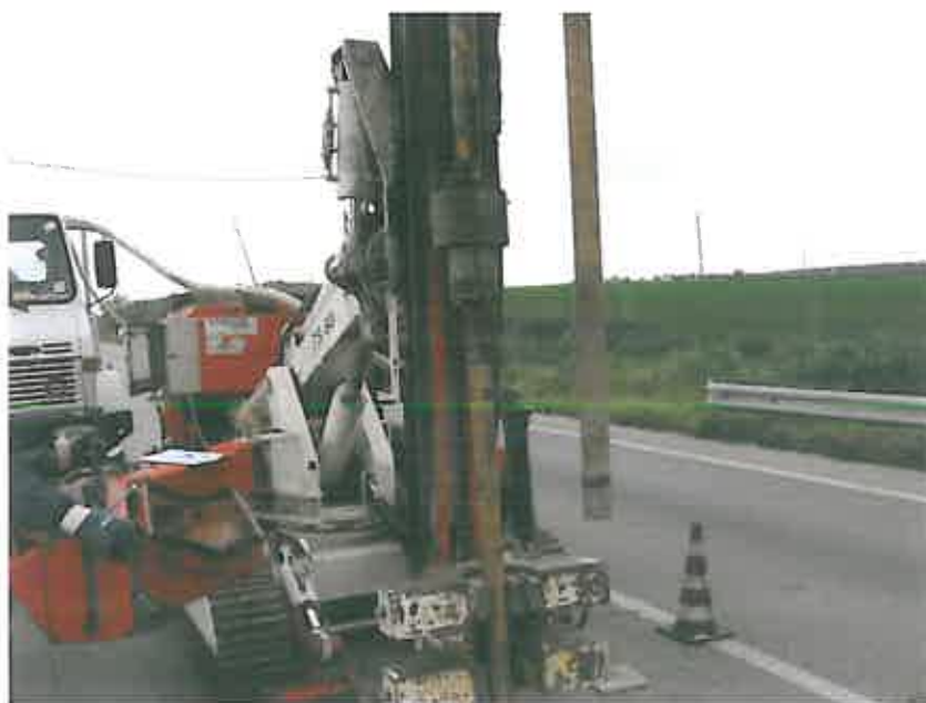
Fig.6 - Prova SPT nel corso dei sondaggi
