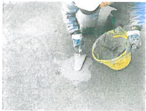
Foto 2 : Ripristino foro d'ispezione
