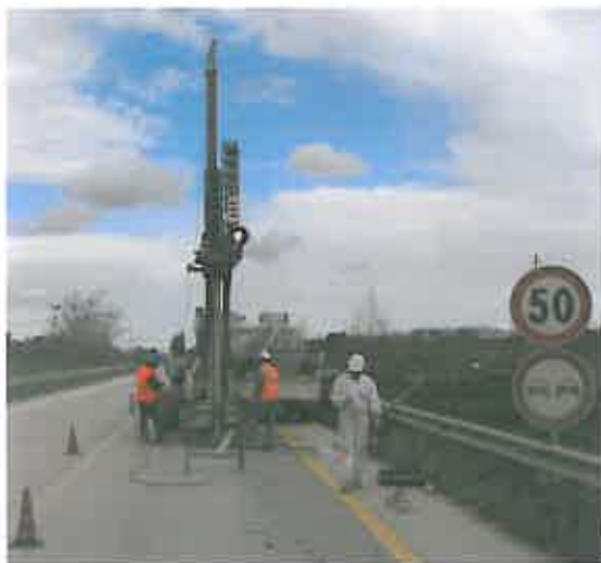
Fig.2 - Perforazioni geognostiche a carotaggio continuo - Cassetta C1 del PG1
