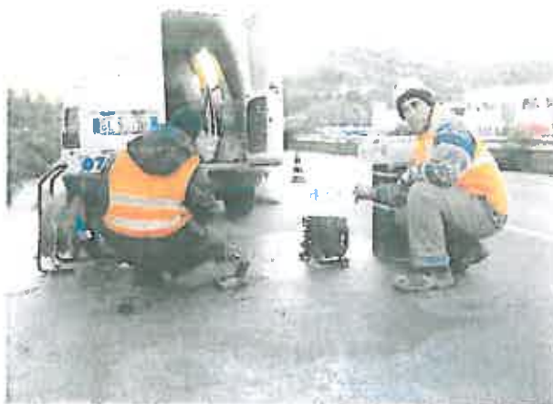
Foto 1 : Vista del sito oggetto di indagine
