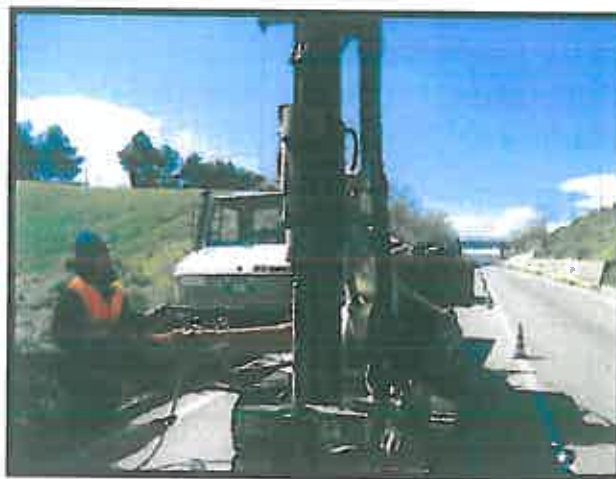
Figura 2: Esecuzione prove S.P.T
