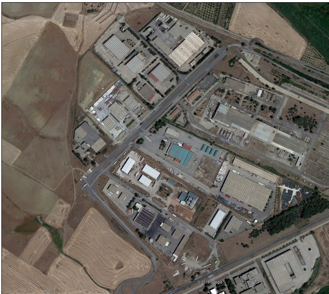
Stato di fatto: Via Pasquasia
