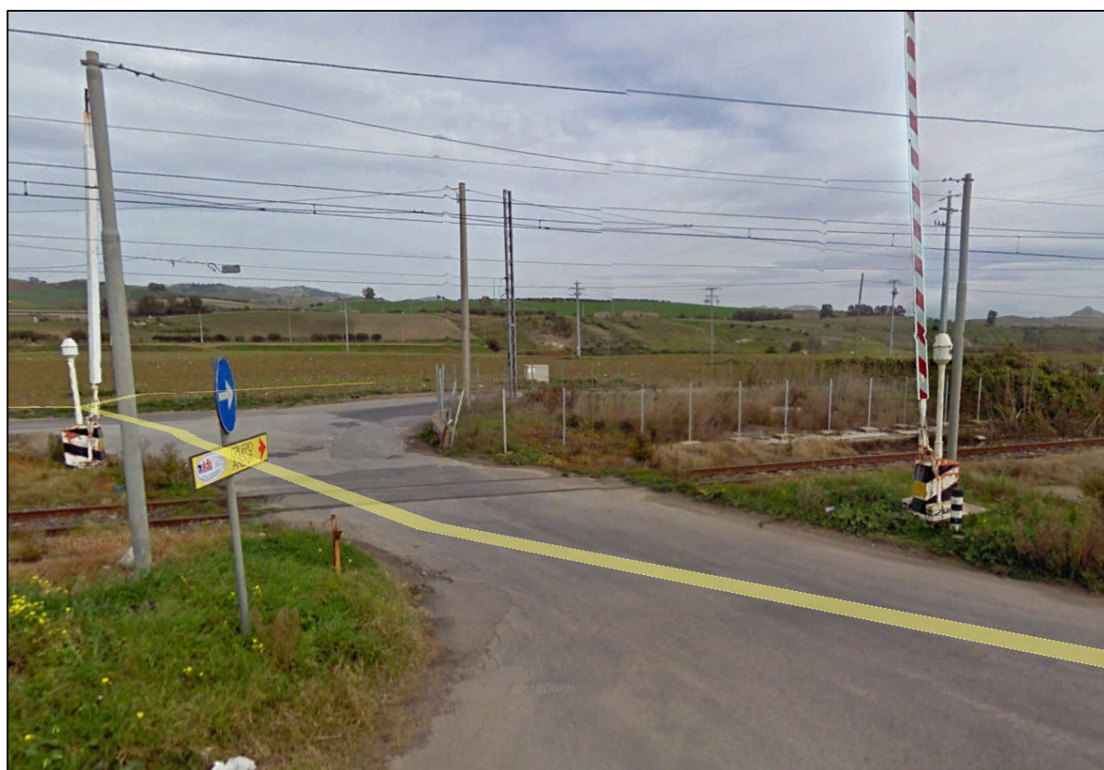
Stato di fatto: SP75 Passaggio a livello
