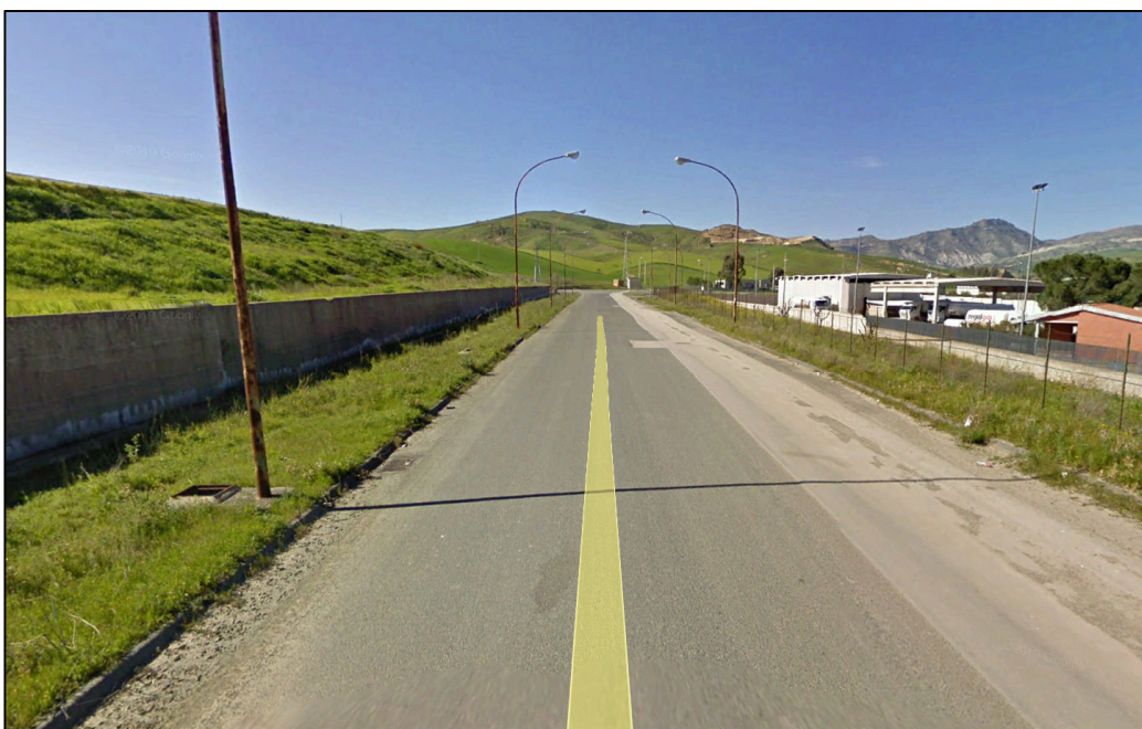
Stato di fatto: Sezione Via Pasquasia all'uscita dall'intersezione sulla SS192
