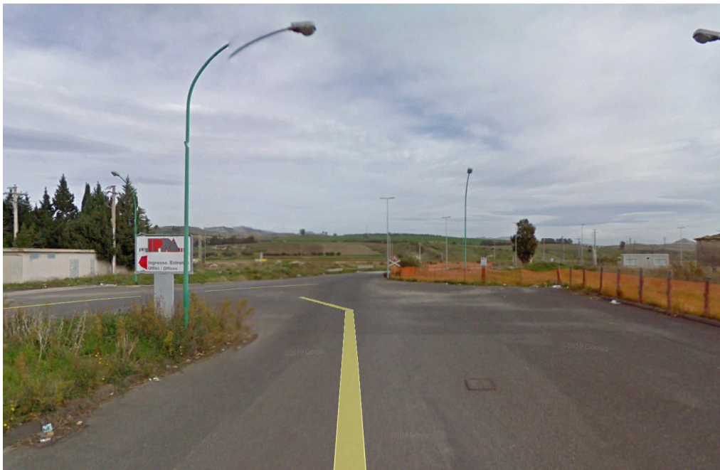
Stato di fatto: Zona torna indietro Via Pasquasia all'interno dell'area industriale
