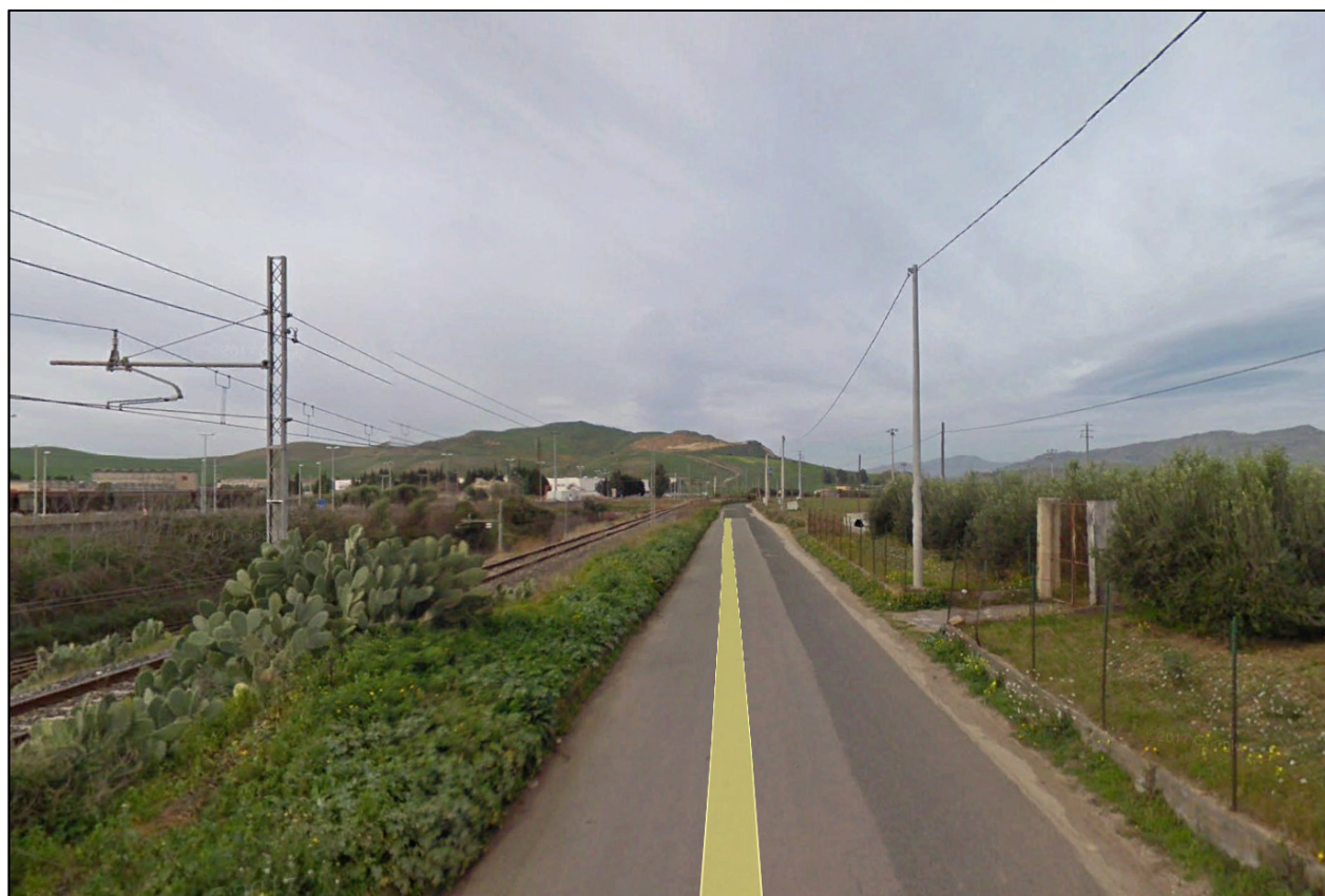
Stato di fatto: Provinciale SP57
