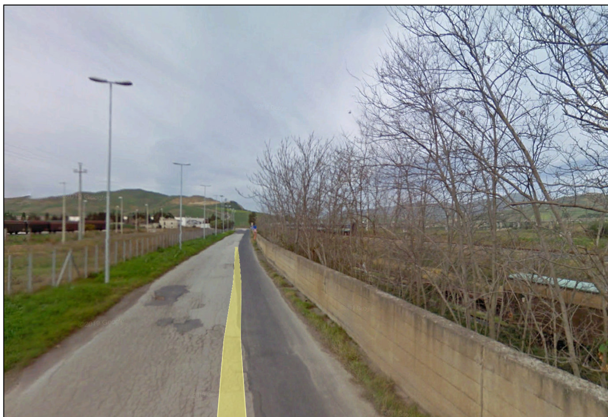
Stato di fatto: SP75 prima del passaggio a livello
