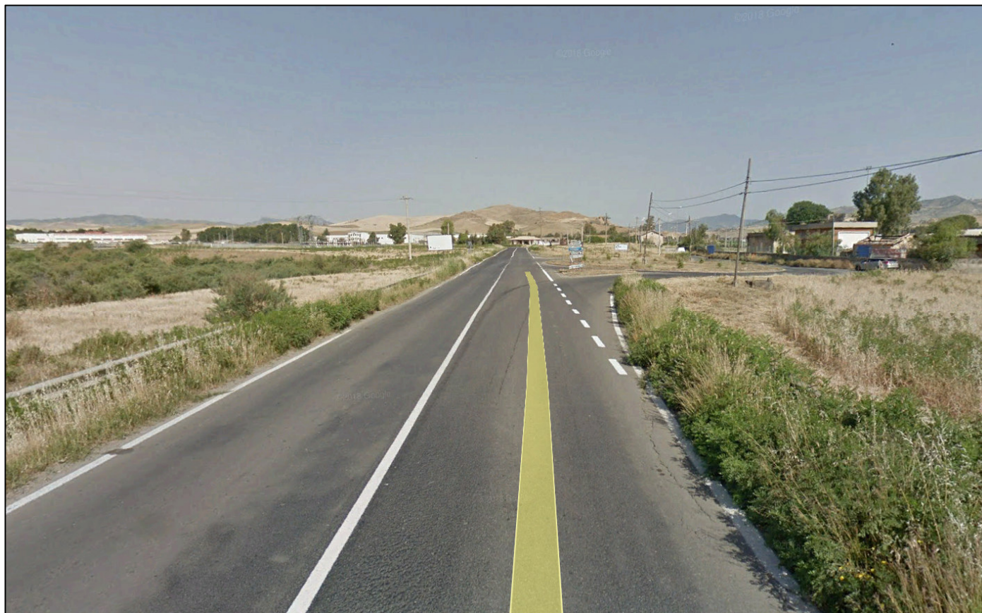
Stato di fatto: S.S. 192 della Valle del Dittaino - progr. 18+800 (progressive Anas)
