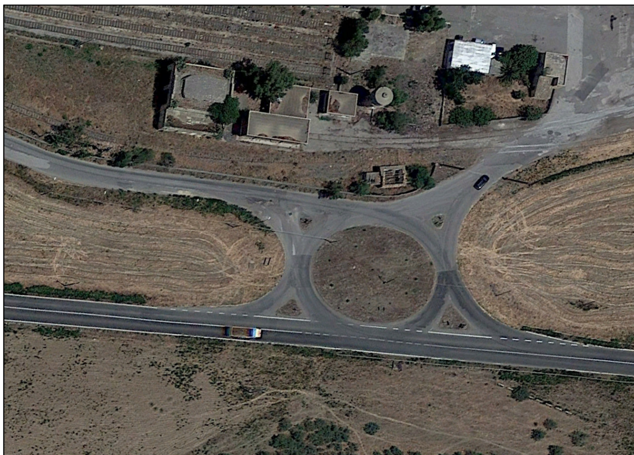
Stato di fatto: S.S. 192 della Valle del Dittaino - progr.18+800 (progressive Anas)
