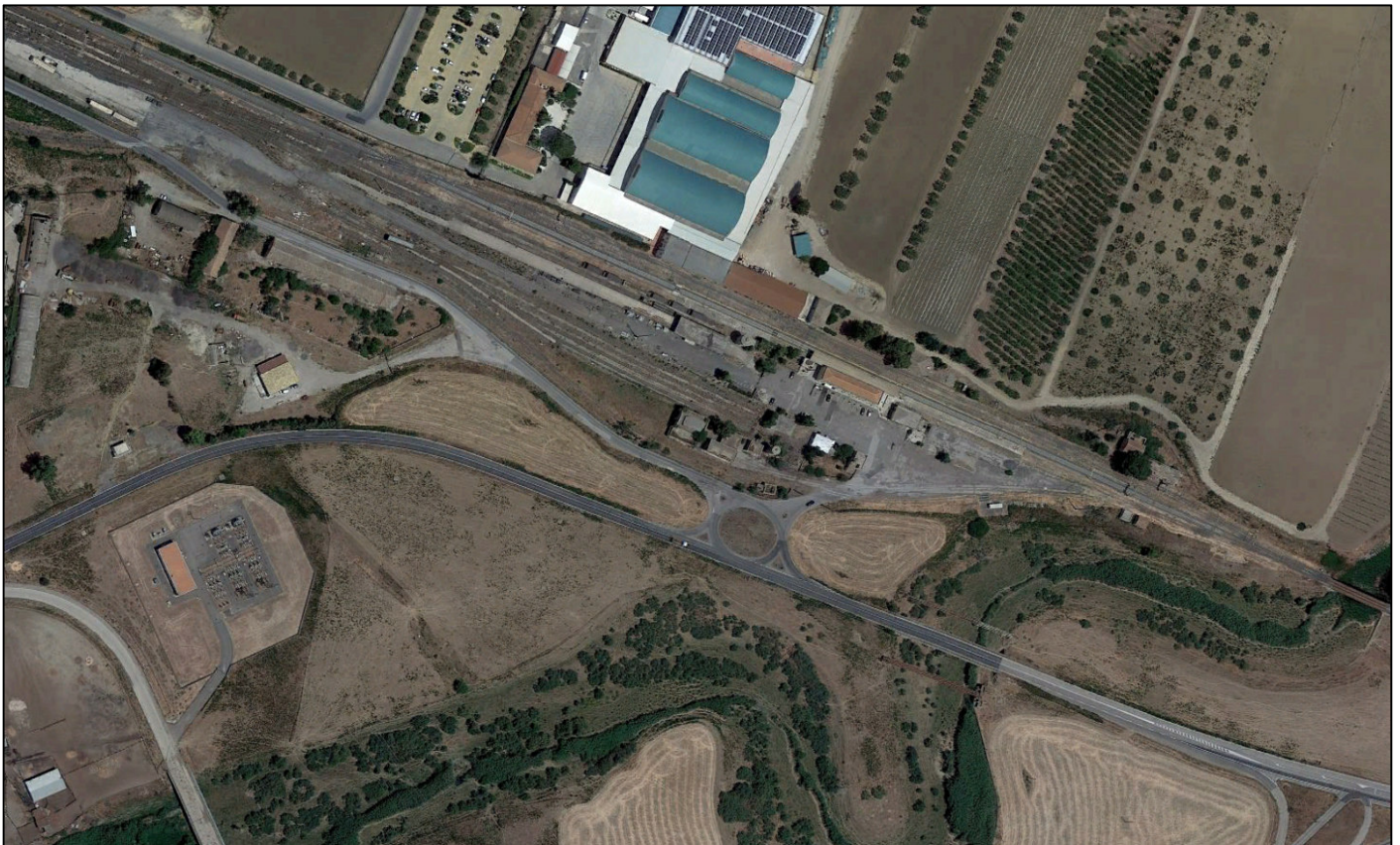
Stato di fatto: S.S. 192 della Valle del Dittaino - progr.18+800 (progressive Anas)
