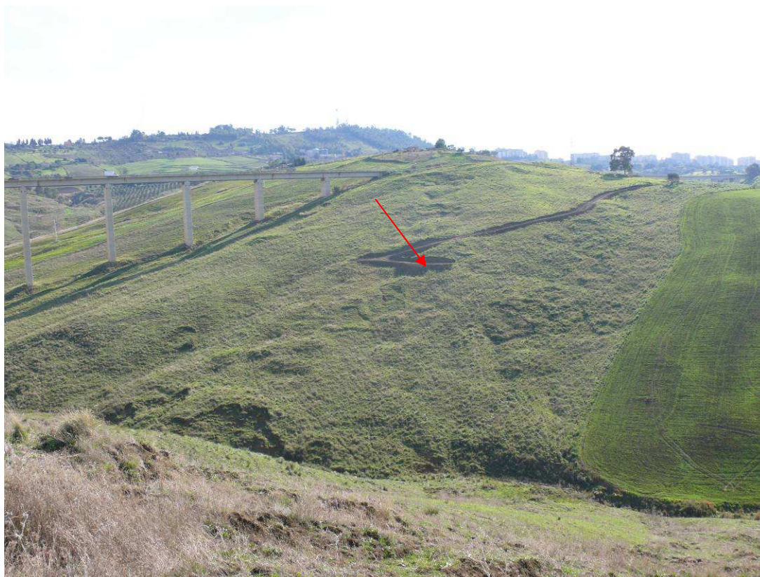
Fig. 7.5.7 – Versante in sinistra orografica del vallone che attraverserà il VD Busita II; sono evidenti forme di dissesto gravitativi superficiale che interessano diffusamente il versante; la freccia indica l'inclinometro SI31 di recente installazione
