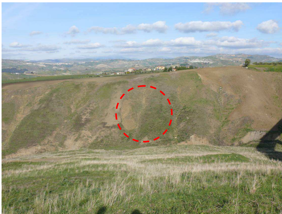
Fig. 7.5.6 – Versante in destra orografica del vallone che attraverserà il VD Busita II; sono evidenti forme di erosione calanchiva e piccoli fenomeni di dissesto gravitativo superficiale, presenti in corrispondenza della spalla 2 del viadotto (v. cerchietto rosso), mentre la freccia rossa indica la zona di accumulo al piede di dissesti passati, che la sismica a rifrazione ha individuato con spessore nell'ordine dei 10 m.
