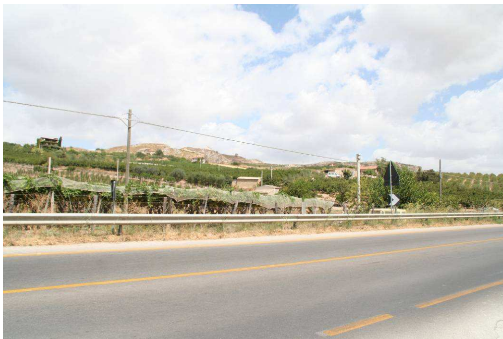
Foto 1 Tracciato attuale della SS640 alla progr. 0+150
