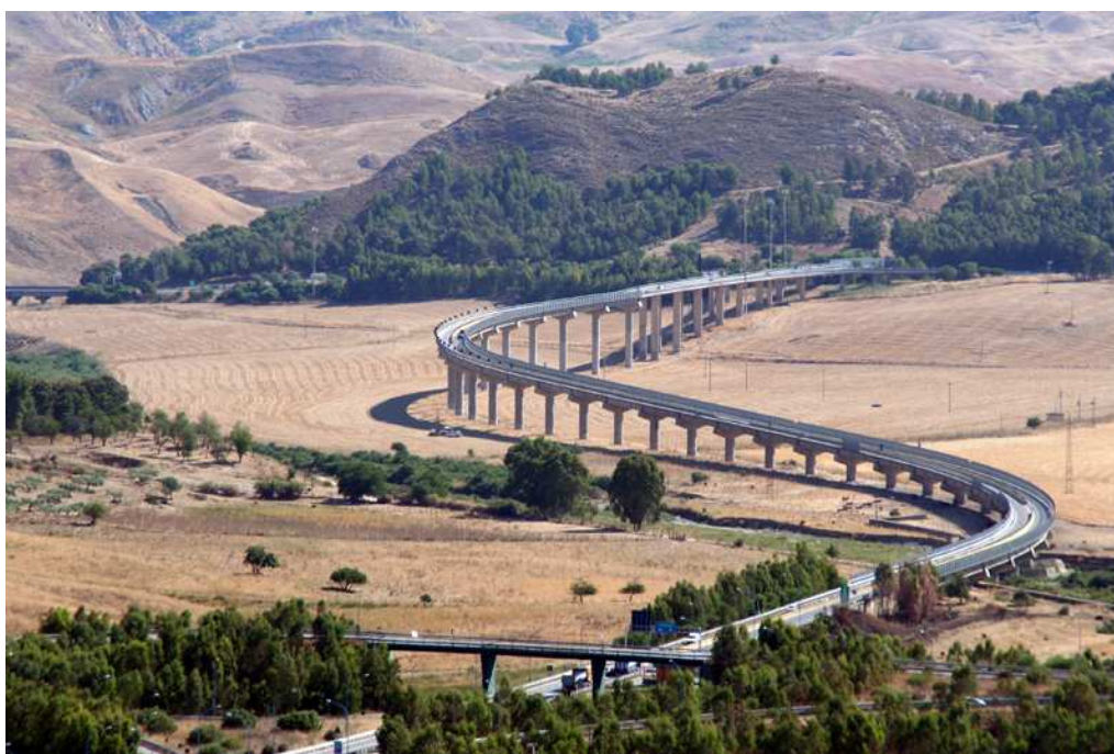
Foto 16 – Tratto 3-C: Viadotto attuale su valle del F.me Salso
