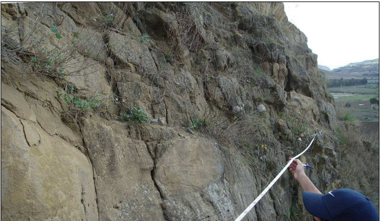
Figure 7 e 8 - Panoramica stazione1 e scanline (sopra); dettaglio (sotto).
