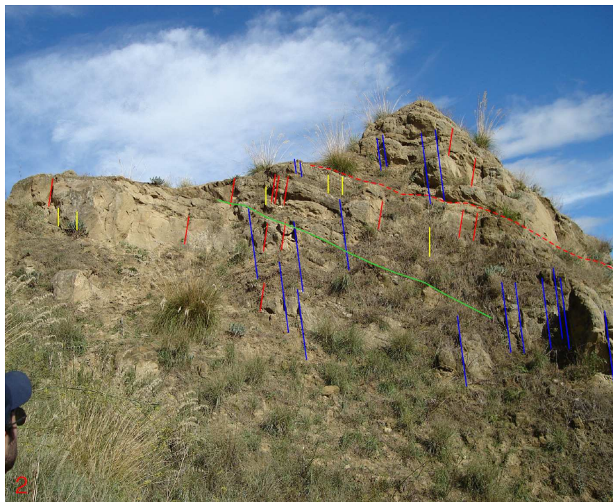
Figura 13.2 - Panoramica della stazione 1, con rappresentazione schematica delle principali discontinuità.
