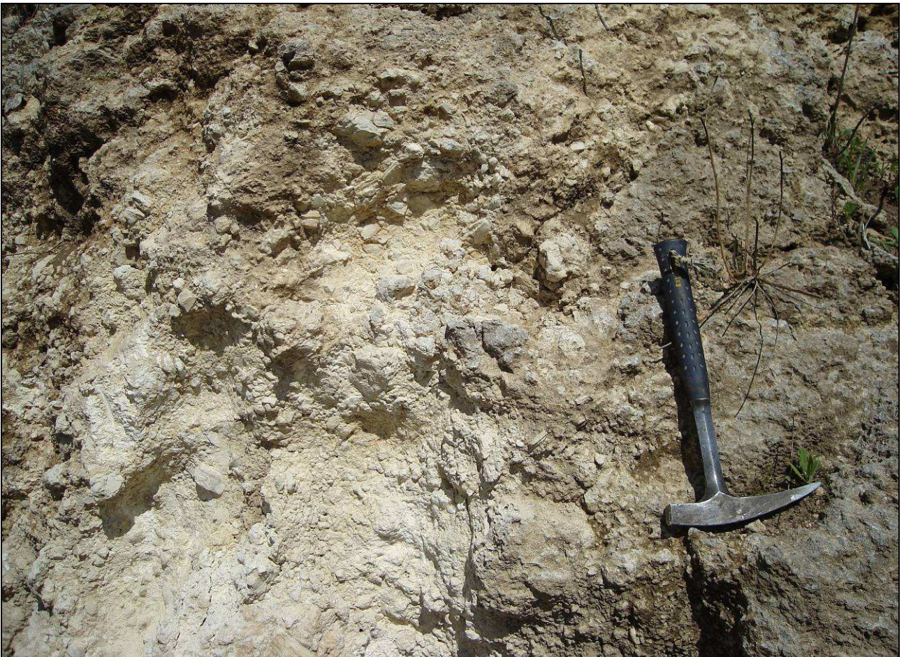
Figure 19 e 20 - Panoramica Stazione 4 (sopra) e dettaglio (sotto).
