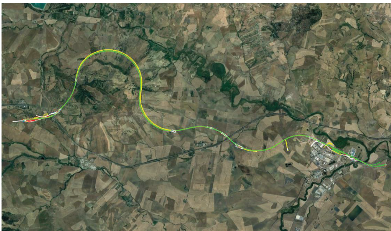
Figura 2-1 Vista aerea dell'inquadramento generale dell'intervento oggetto di studio
