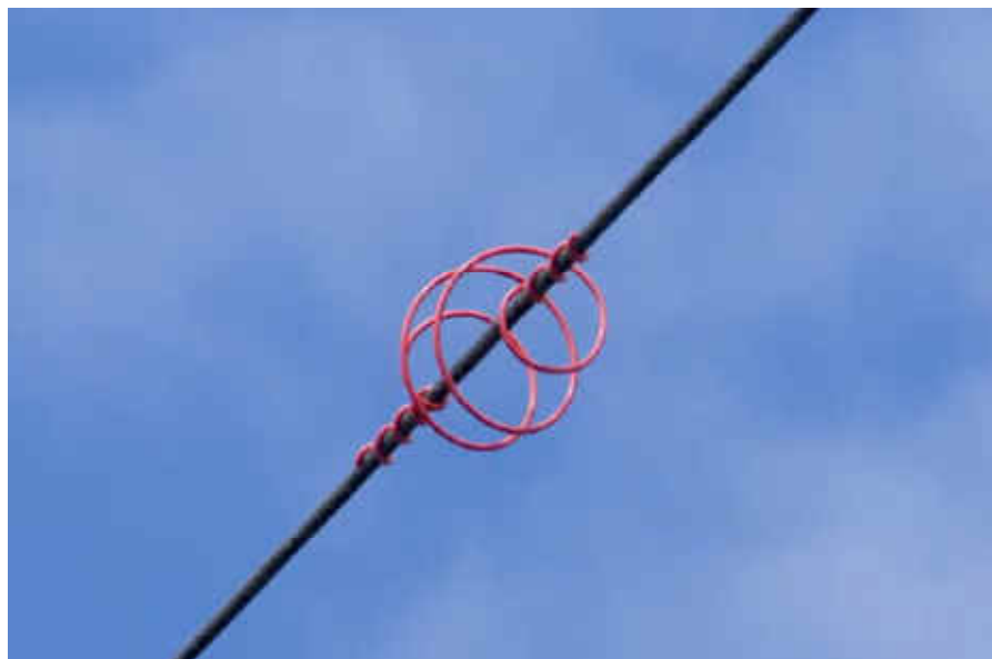
Figura 4-VI. Spirale colorata in plastica per la segnalazione dei cavi
