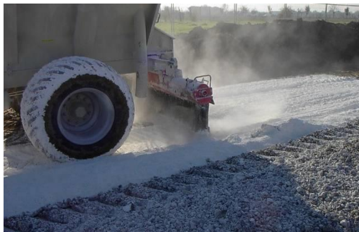
FIGURA 4-40 – STABILIZZAZIONE DELLE TERRE – SPANDIMENTO DEL LEGANTE (CALCE IN FIGURA)
