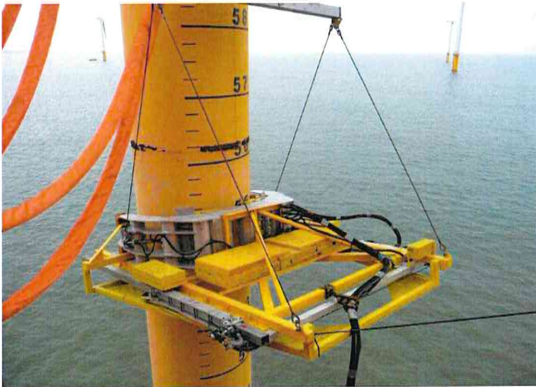
Figura 10-16 – Sistema di taglio DWCS per taglio a cavo diamantato - Tipico
