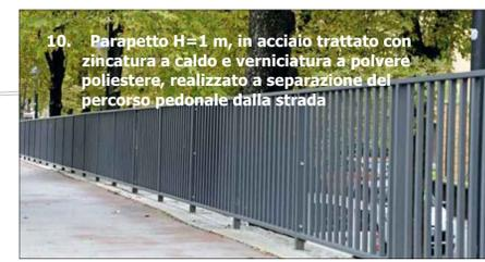
10. Parapetto H=1 m, in acciaio trattato con zincatura a caldo e verniciatura a polvere poliestere, realizzato a separazione del percorso pedonale dalla strada
