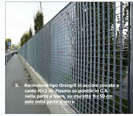
5. Recinzione tipo Orsogril in acciaio zincato a caldo H=2 m. Fissato su pontile in C.A. nella parte a mare, su muretto H=50 cm solo nella parte a terra
