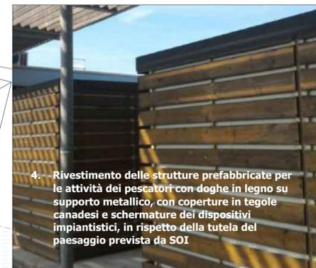
4. Rivestimento delle strutture prefabbricate per le attività dei pescatori con doghe in legno su supporto metallico, con coperture in tegole canadesi e schermature dei dispositivi impiantistici, in rispetto della tutela del paesaggio prevista da SOI
