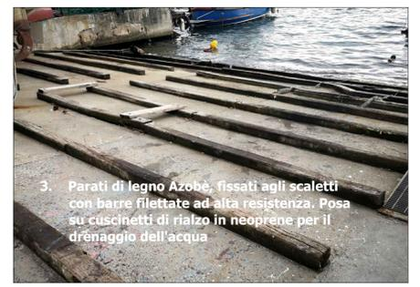
3. Parati di legno Azobé, fissati agli scaletti con barre filettate ad alta resistenza. Posa su cuscinetti di rialzo in neoprene per il drenaggio dell'acqua
