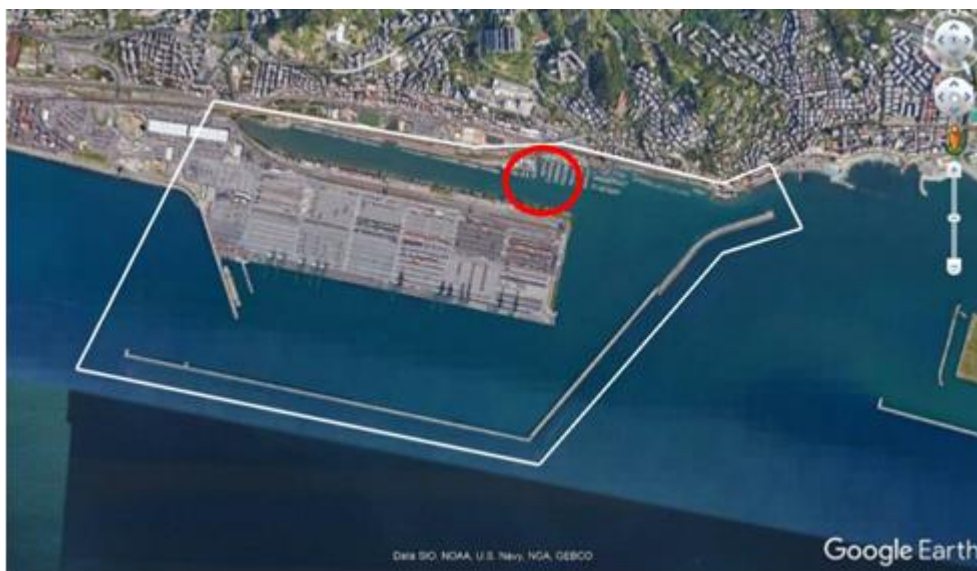
Figura 1 Delimitazione dell'intera area del bacino di Prà-Voltri, con evidenziata in rosso la zona oggetto di intervento all'imbocco del canale di calma di Prà
