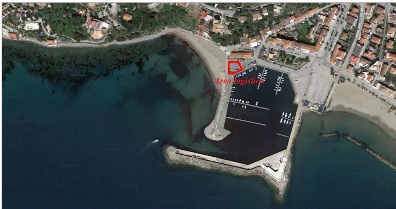
Figura 3 - Ubicazione Area logistica
