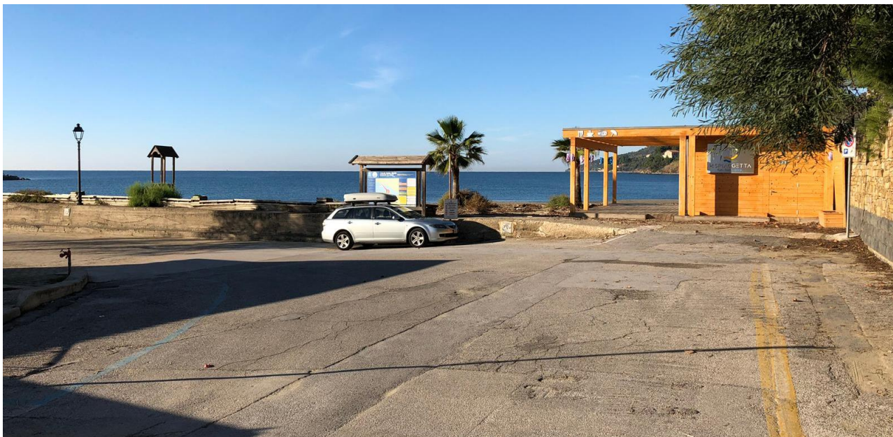
Figura 3 - Interferenza per accesso alla zona operativa 1 - Necessaria realizzazione rampa per scavalcare muro e permettere ai mezzi di raggiungere l'area operativa 1
