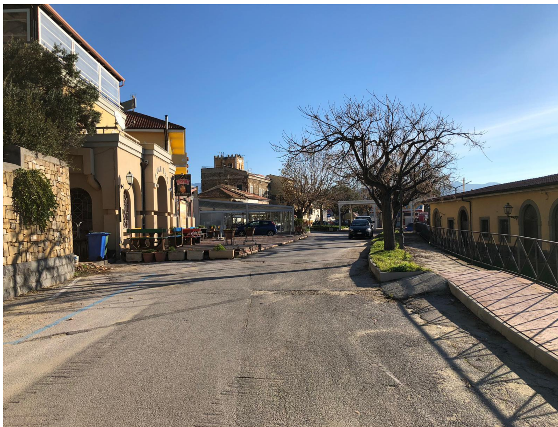
Figura 6 - Viabilità di cantiere lungo vie comunali ordinarie
