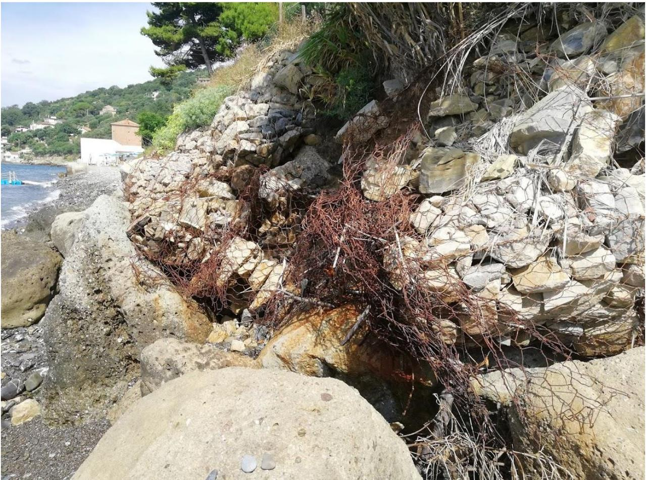
**Foto 9: intervento per la sistemazione del versante. Intervento mal eseguito e con materiali non idonei.**
