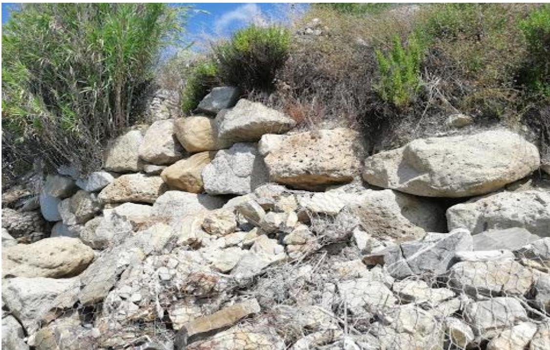
**Foto 10:** nelle foto 9 e 10 si vede l'intervento realizzato per la sistemazione del versante, sottostante strada di accesso alla spiaggia, mal eseguito con gabbioni e massi, di dimensioni variabili, "appoggiati". Stato dei gabbioni molto ammalorato. Facilmente erodibili e scalzabili dall'azione del moto ondoso.
