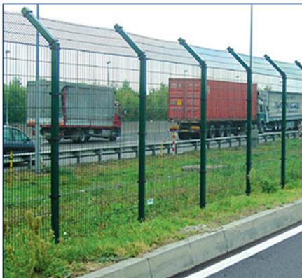
La recinzione continua lungo il perimetro dell'area d'impianto sarà costituita da elementi modulari rigidi in tondini di acciaio elettrosaldati di diverso diametro che conferiscono una particolare resistenza e solidità alla recinzione. Essa offre una notevole protezione da eventuali atti vandalici, lasciando inalterato un piacevole effetto estetico e costituisce un sistema di fissaggio nel rispetto delle norme di sicurezza.
